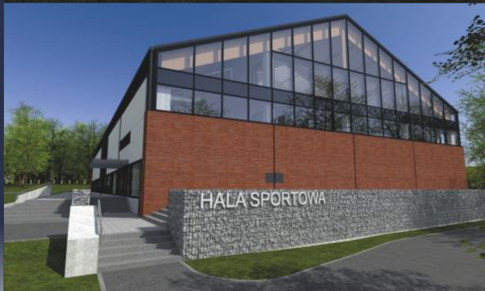
fot / BR Pracownia Architektoniczna
