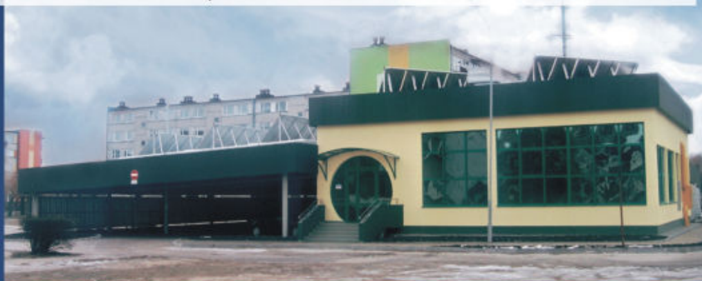
Budowa Roku Podkarpacia 2005 – Kociołnia Gazowa w Lubaczowie
