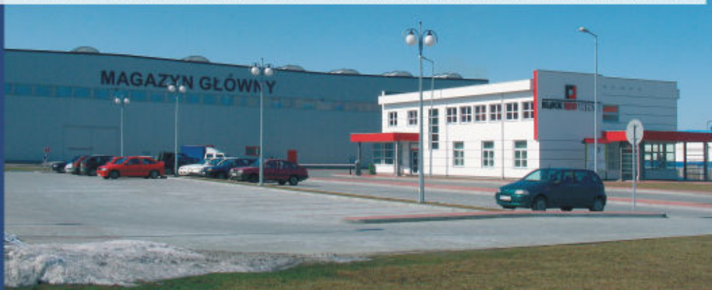
Budowa Roku Podkarpacia 2005 – Centrum Logistyczne BRW Sp. z o.o. w Mielcu
