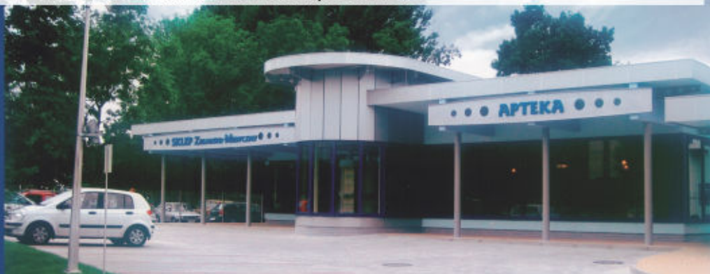
Budynek usługowo-handlowy CEFARM Rzeszów – nagroda II stopnia w konkursie Budowa Roku Podkarpacia 2005
