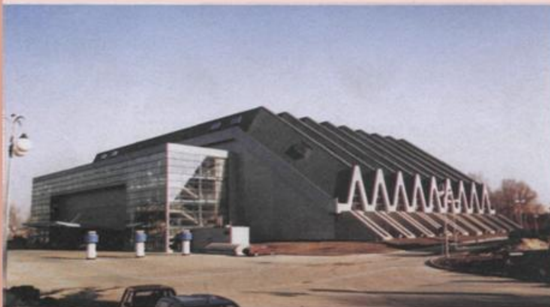
Fot. 7. Hala widowiskowo – sportowa w Rzeszowie po modernizacji
