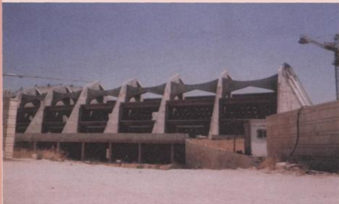
Fot. 10. Hala sportowa ASC Aleppo – Syria; stan zaawansowania robót w 2004 r.
