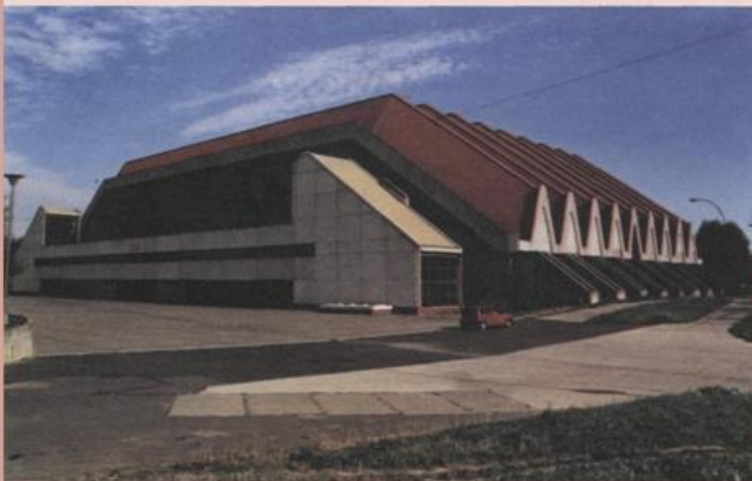
Fot. 6. Hala widowiskowo – sportowa w Rzeszowie przed modernizacją
