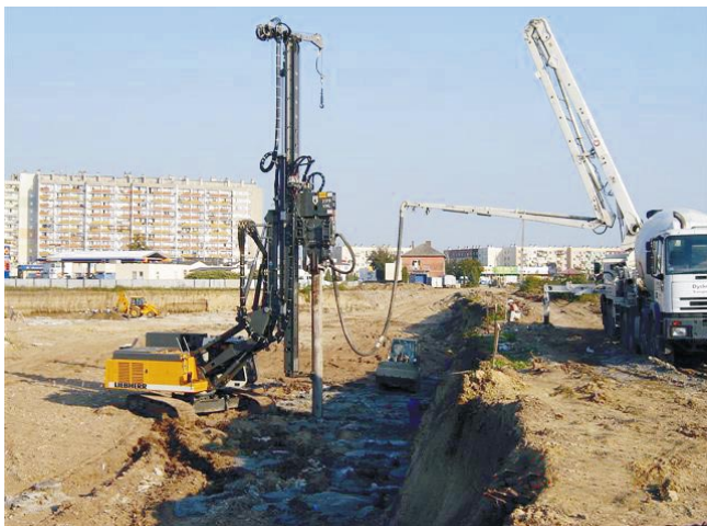
Palowanie terenu pod budowę Millenium Hall w Rzeszowie
