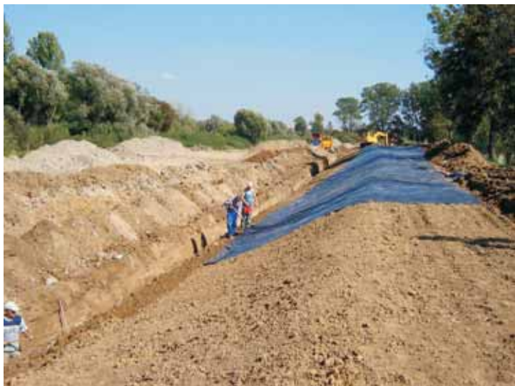
Uszczelnianie korpusu wału
