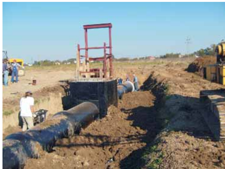
Wieża zamknąć głębinowych śluza km 1+746
