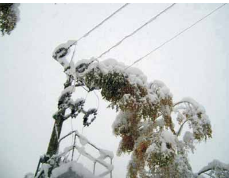
Stacja transformatorowa Chmiel 1
