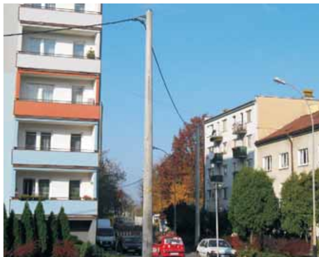
Przebudowa rzeki Mikośka. Zasilanie energetyczne przy ul. Z. Chrzanowskiej w Rzeszowie
