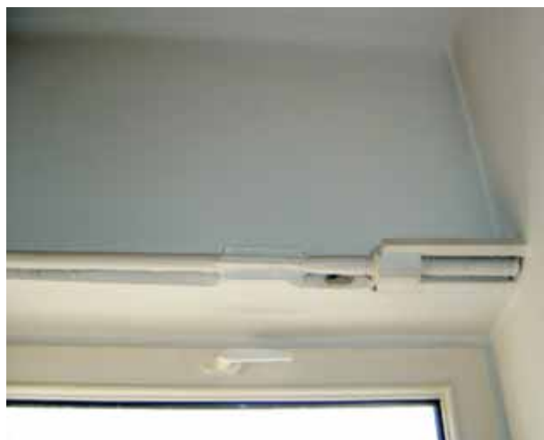
Rys. 3. Fragment ściągu stalowego nad VI piętrem
