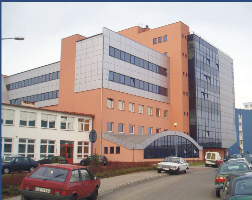
Budynek „P” Wydziału Budownictwa Inżynierii i Środowiska Politechniki Rzeszowskiej
