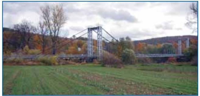
Kładka wisząca pieszo-jezdna w Krasiczynie
