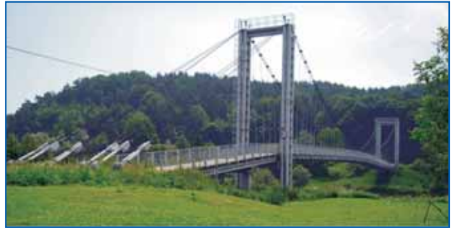
Kładka pieszo-jezdna w Olszanach
