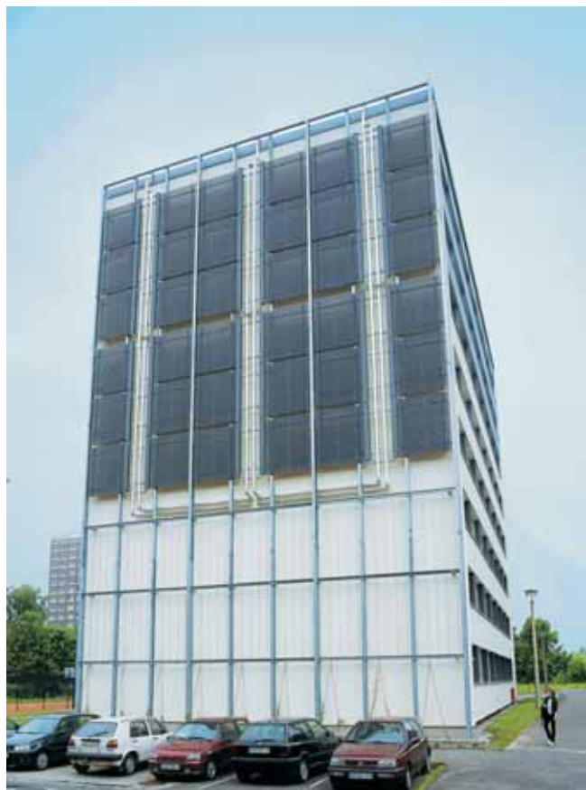
Duża instalacja kolektorów Vitosol 200-T.
