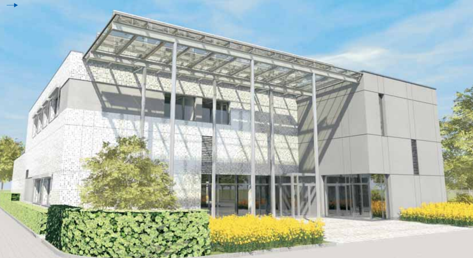
Widok budynku od strony drogi.
