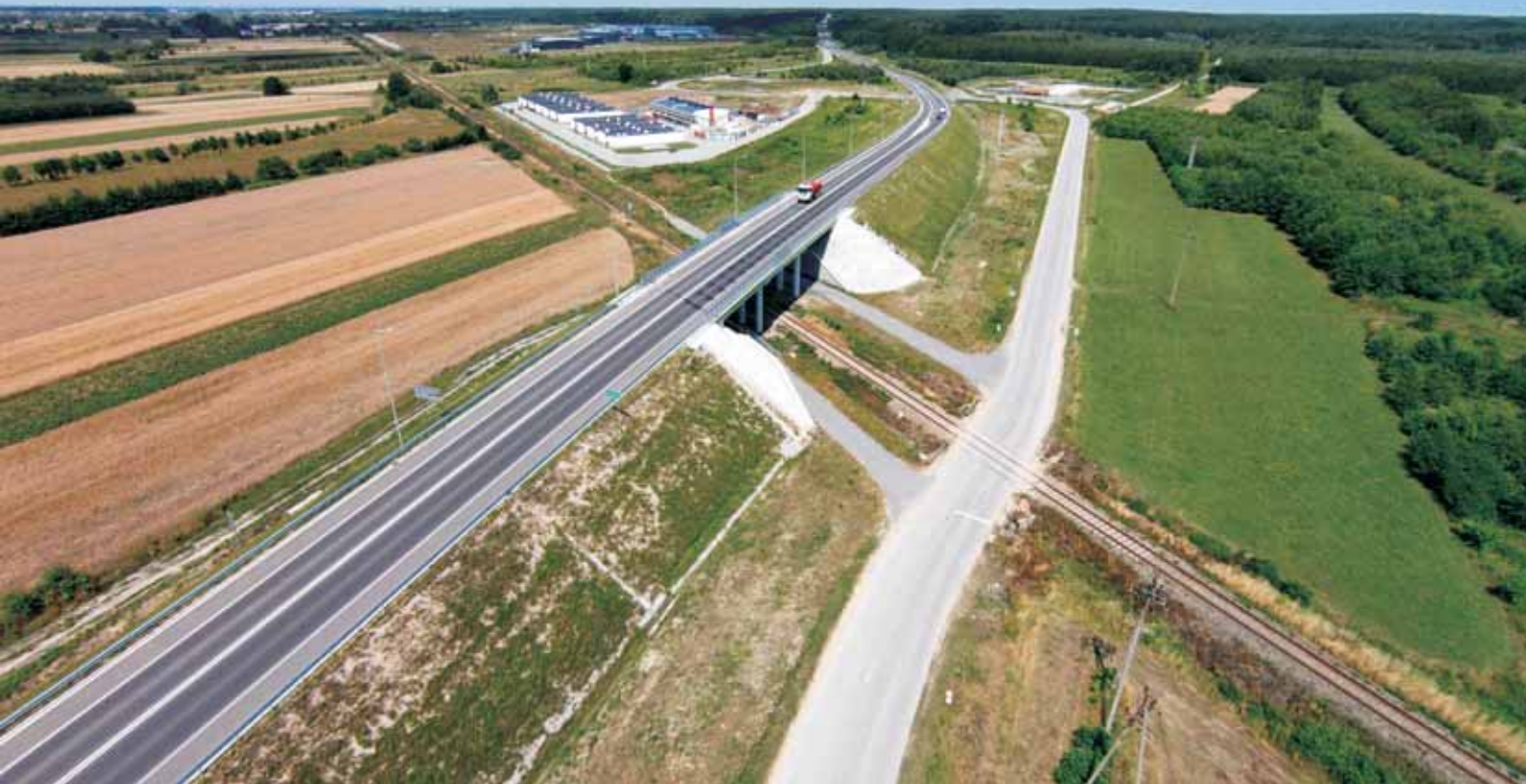
Wiadukt w Rzochowie (skrzyżowanie DW 985 z linią kolejową nr 025 Łódź Kaliska - Dębica)
