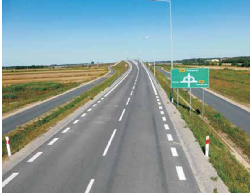
Dojazd do węzła w Tuszowie Narodowym
