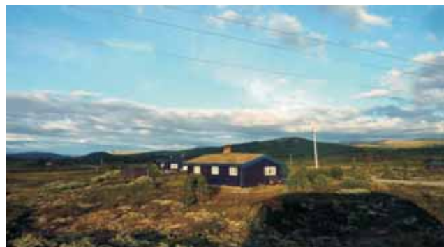
Budynek mieszkalny z zielonym dachem na płaskowyżu Hardangervidda
