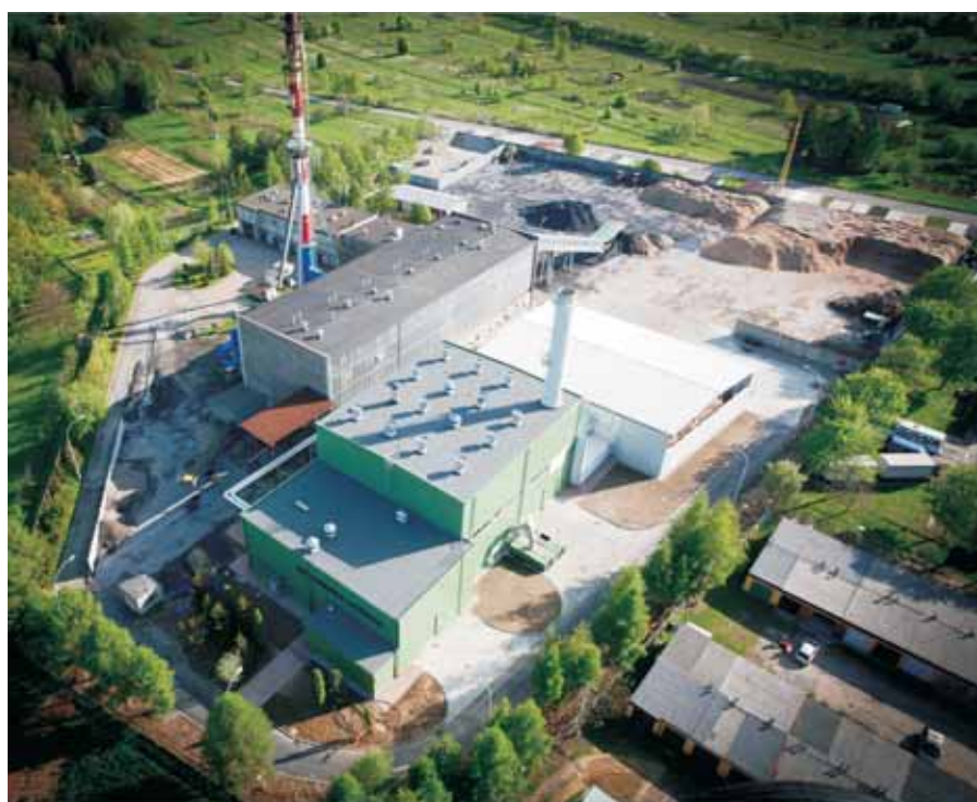
Ciepłownia Łężańska w Krośnie
