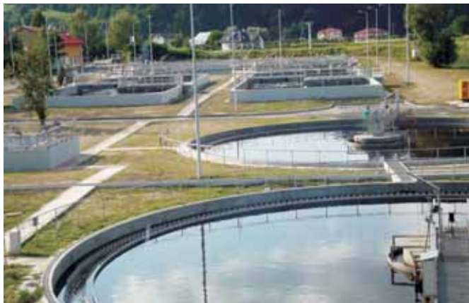
■ Osadniki wtórne oczyszczalni ścieków w Trepczy denitryfikacji
