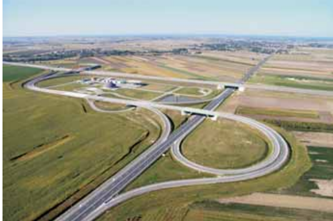
Budowa autostrady A-4
