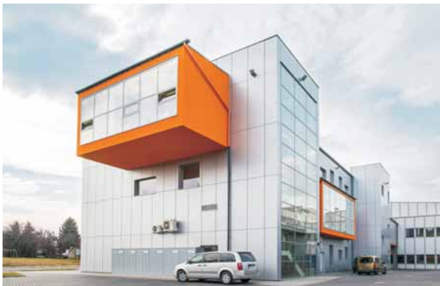
Budynek Zespołu Laboratoriów Politechniki Rzeszowskiej
