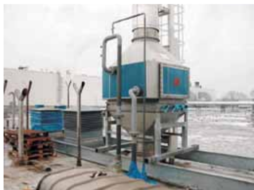
Rekuperator dla kotła parowego o wydajności 7,0 t/h
