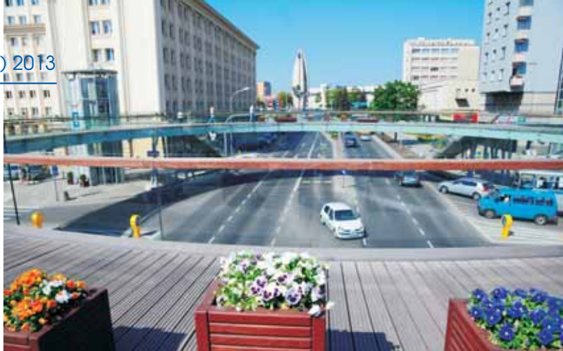
Kładka dla pieszych w Rzeszowie biegnąca nad fragmentem jezdni ul. Piłsudskiego
