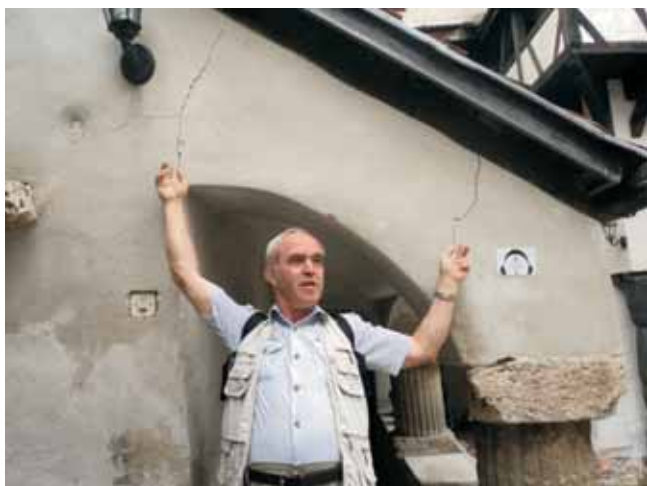
Zamek w Bran - kolega Tadeusz Dusak wykonuje ekspertyzę stanu technicznego budowli.
