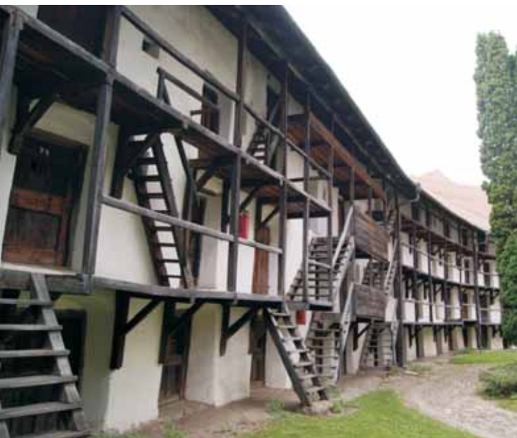
System schodów prowadzących do pomieszczeń mieszkalnych - praprapradziadek mieszkalnego bloku.
