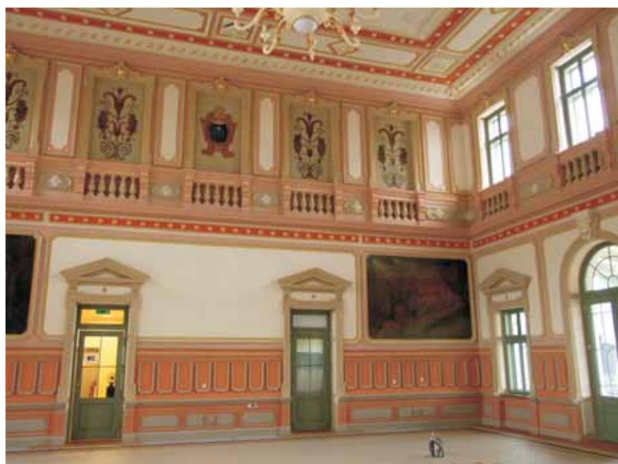
Przebudowa Dworca Kolejowego w Przemyśle.
