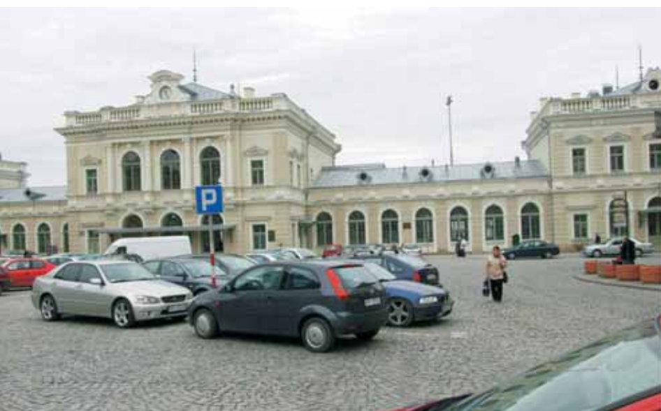
Przebudowa Dworca Kolejowego w Przemyśle.
