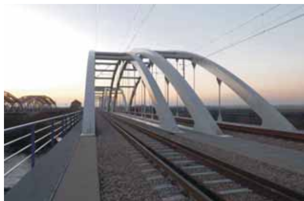
Most kolejowy nad Wisłoką, odc. E30 Kraków - Rzeszów.
