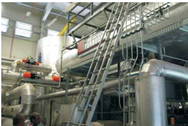
Fragment pomieszczenia kotłowni.
