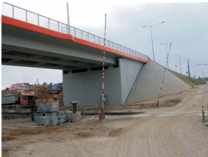
Budowa wiaduktu nad linią kolejową PKP LHS w miejscowości Nowa Dęba w ciągu drogi krajowej Nr 9 Radom - BARWINEK realizowana przez SKANSKA S.A. Oddział Budownictwa Inżynieryjnego w Rzeszowie
