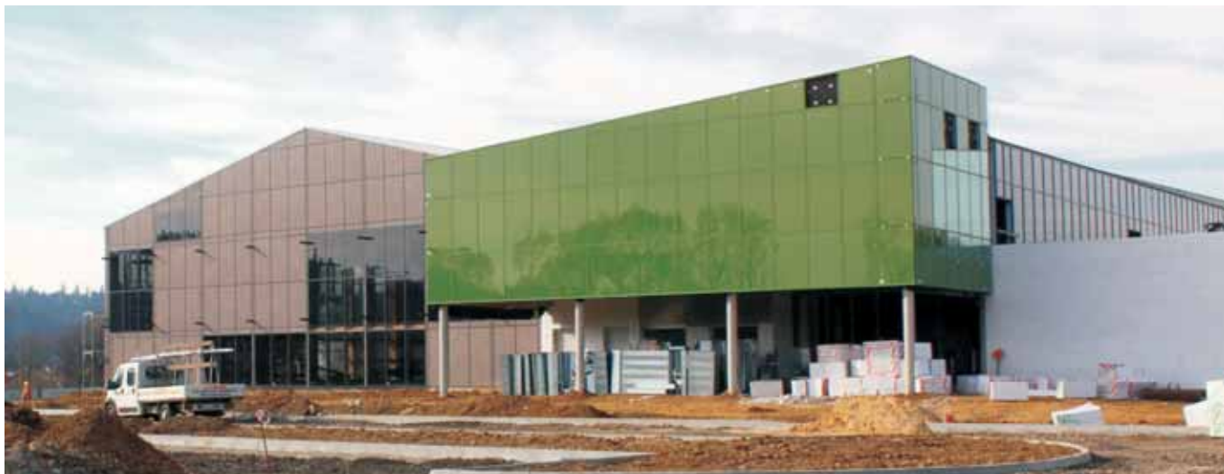
Budowa pierwszej części Kompleksu Sportowo-Rekreacyjnego - budynek pływalni w Lesku - generalny wykonawca: SKANSKA S.A. Oddział Budownictwa Ogólnego w Rzeszowie
