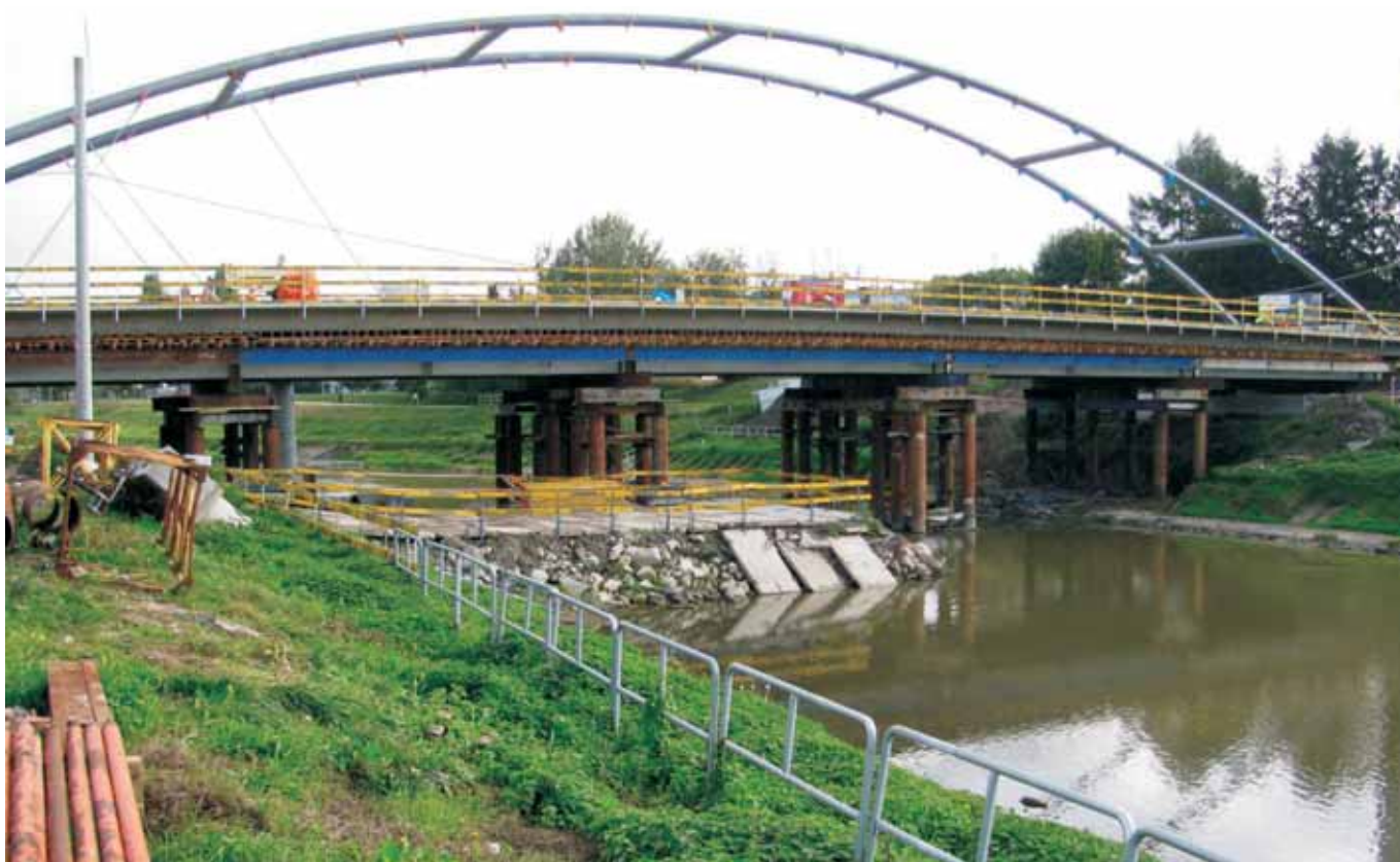
Budowa mostu drogowego nad rzeką Wisłok w Rzeszowie w ciągu ulic Naruszewicza i Wierzbowej - wykonawca: SKANSKA S.A. Oddział Budownictwa Inżynieryjnego w Rzeszowie
