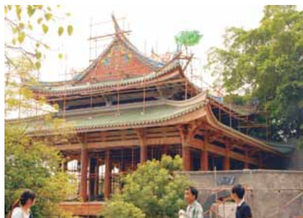
Remont starej świątyni.
