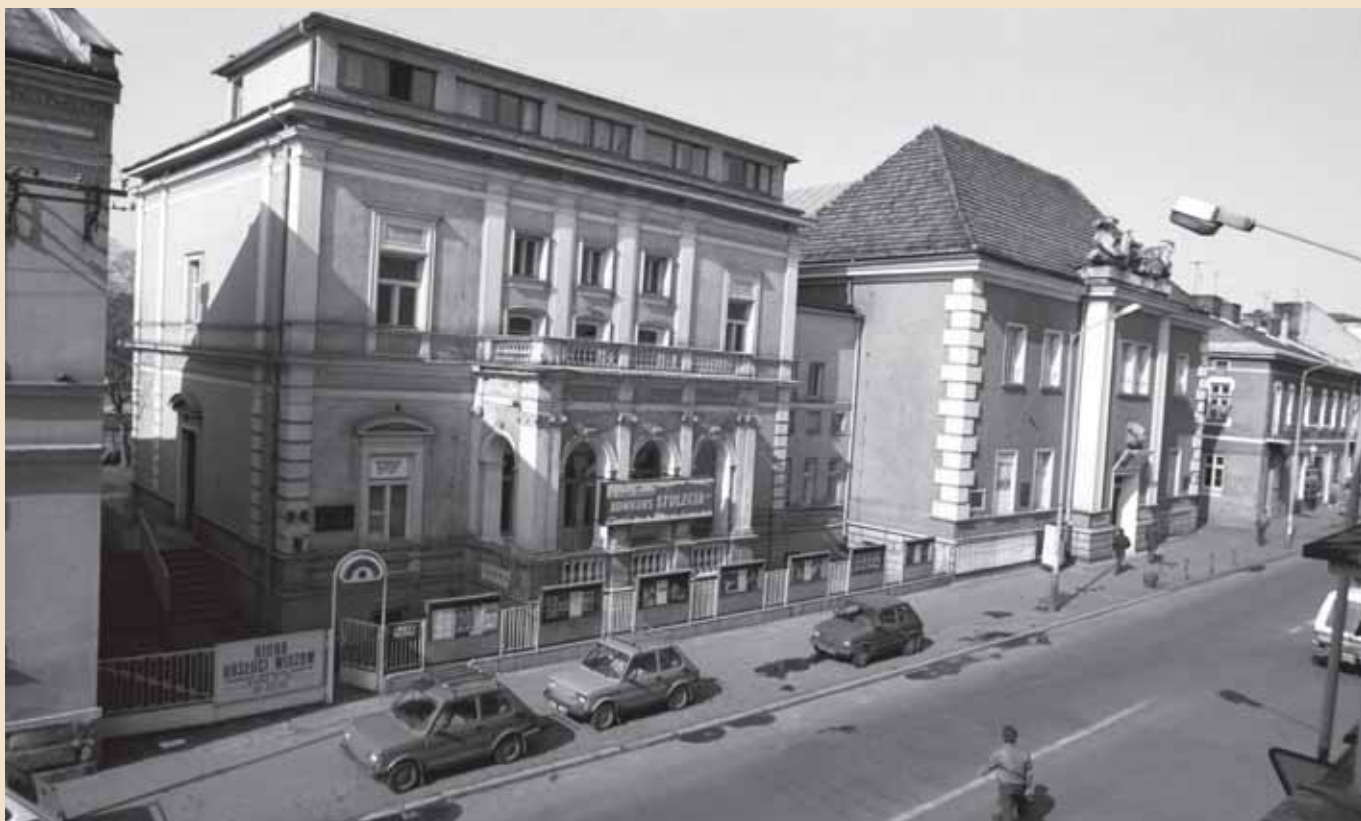
W latach 60. XX w. przepiękna elewacja budynku została zniszczona. Jej pierwotny wygląd przywrócono dopiero w 2006 r. Fot. Irena Gałuszka.
