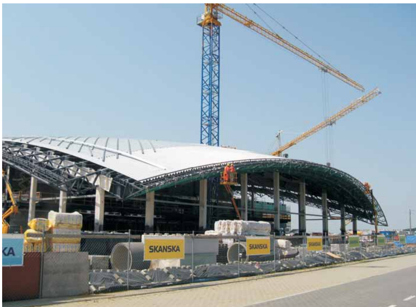
Budowa terminala odpraw pasażerskich na lotnisku w Jasionce.
