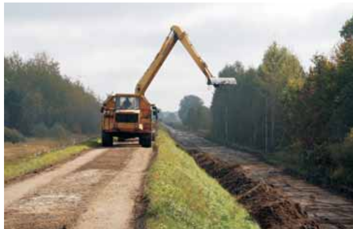
Rozbudowa wałów przeciwpowodziowych na rzece Łęg w gm. Gorzyce
