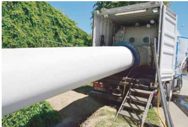
Samochód techniczny montujący rękaw
