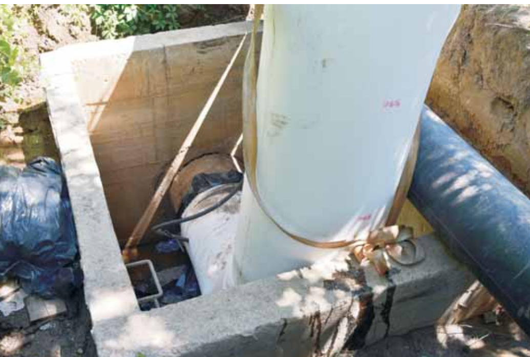
Montaż rękawa w komorze przy ul. Witosa
