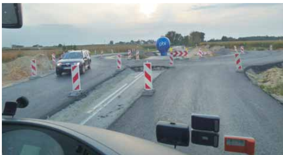
Budowa ronda na odcinku Oleszyce-Lubaczów przez PBI Infrastruktura
