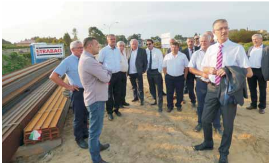
Plac budowy obwodnicy Lubaczowa - na pierwszym planie kierownik budowy
