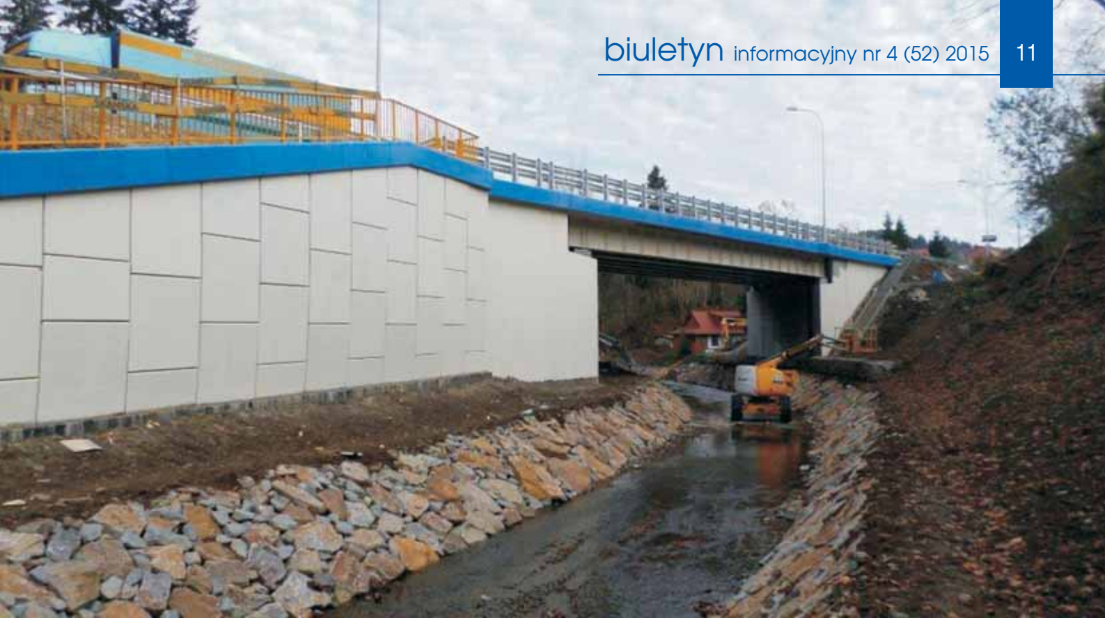
Rozbudowa drogi wojewódzkiej nr 893 Lesko - Cisna wraz z przebudową mostu w miejscowości Cisna
