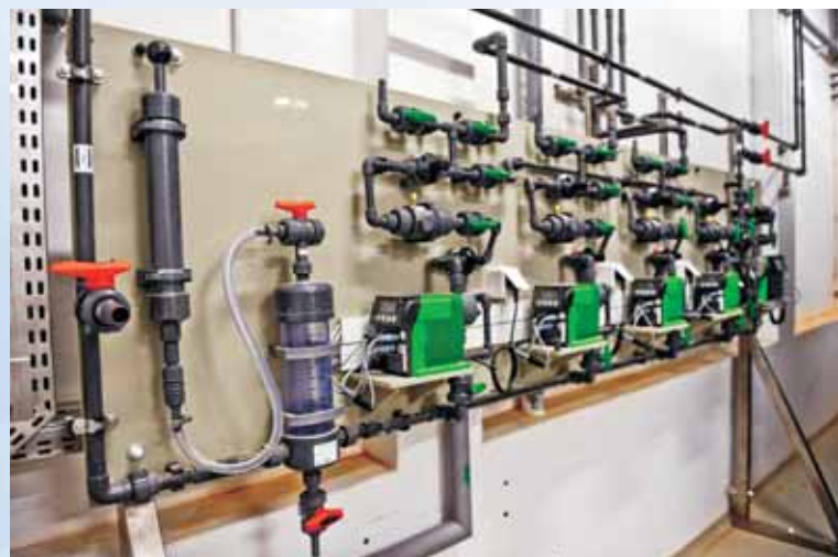
Rozbudowa i modernizacja Zakładu Uzdatniania Wody Sieniawa
