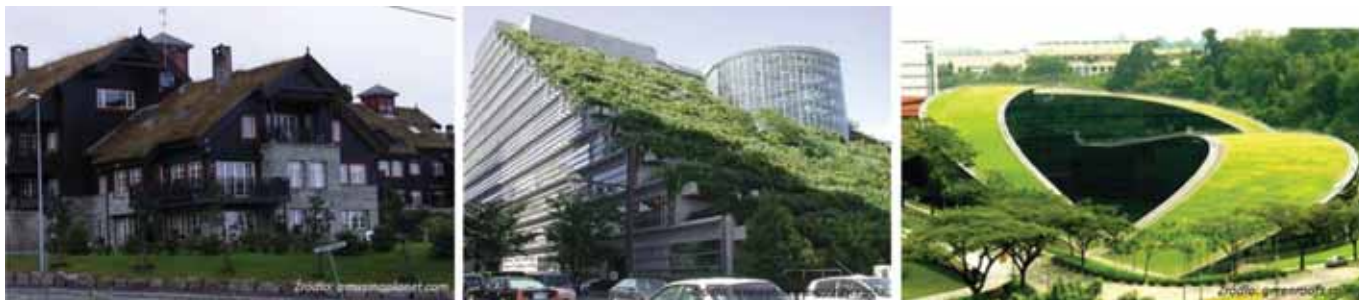
Fot. 1, 2, 3. Charakterystyczne przykładowe zastosowanie zielonych dachów odwróconych o różnych rozwiązaniach, stosowane na różnych rodzajach obiektów budowlanych
