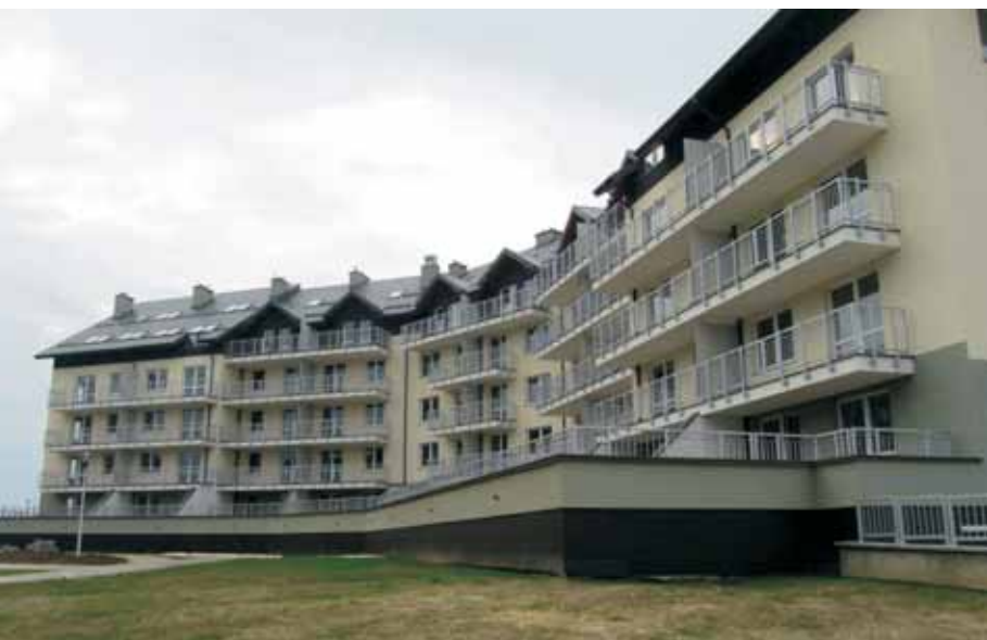
Budynek mieszkalny wielorodzinny nr 3 przy ul. Hallera w Krośnie wykonany przez Krośnieńskie Przedsiębiorstwo Budowlane S.A.
