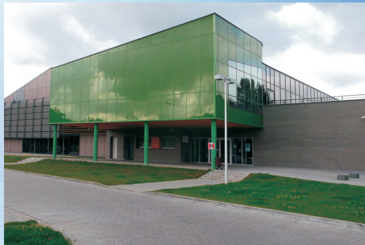
Kompleks sportowo-rekreacyjny etap I - kryta pływalnia, ul. Bieszczadzka, Lesko - nagroda z diamentem
