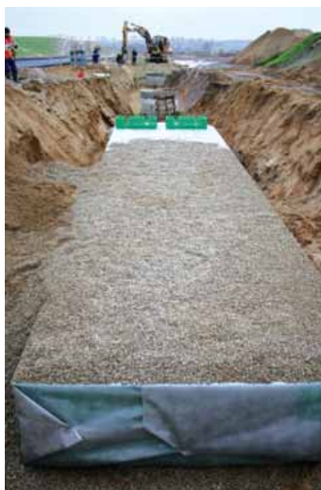
Rys. 8 i 9. Bloki retencyjno-rozsączające do wypełniania infiltracyjnych rowów chłonnych
