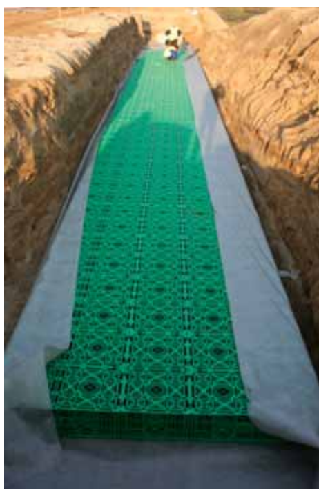
Rys. 8 i 9. Bloki retencyjno-rozsączające do wypełniania infiltracyjnych rowów chłonnych
