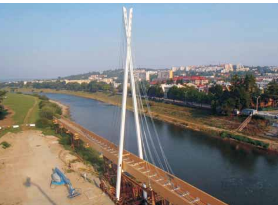
Budowa obiektu mostowego przy ul. Wybrzeże Marszałka Piłsudskiego w Przemyśle realizowana przez firmę SKANSKA S.A. Oddział Budownictwa Inżynieryjnego w Rzeszowie
