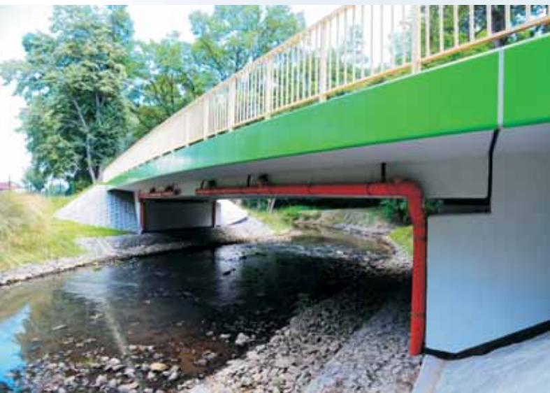
Przebudowa mostu w km 2+224,66 wraz z dojazdami, w ciągu drogi powiatowej nr 1078R Rudnik-Pikuły, Rudnik
