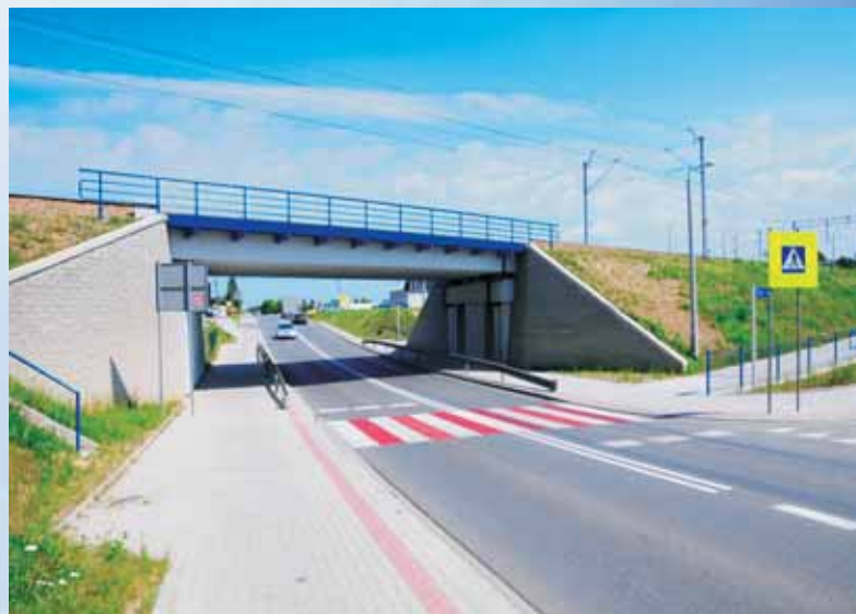
Rozbudowa drogi wojewódzkiej nr 985 Nagnajów - Baranów Sandomierski - Mielec - Dębica - etap II
