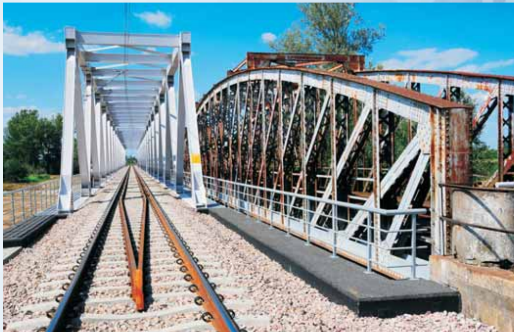
Most stalowy kolejowy w km 167.561 linii nr 68 Lublin-Przeworsk
