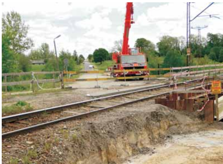
Wzmocnienie podtorza kolejowego na szlaku Sędziszów Młp. - Trzciana
