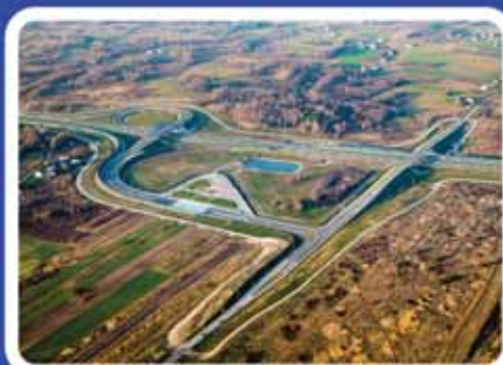
Węzeł autostrady A4 Sędziszów
