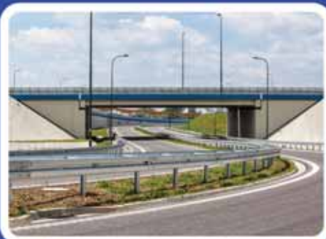
Odcinek autostrady węzeł Rzeszów Północ - węzeł Rzeszów Wschód
