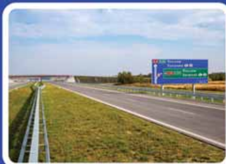
Odcinek autostrady węzeł Dębica Wschód - węzeł Rzeszów Zachód
