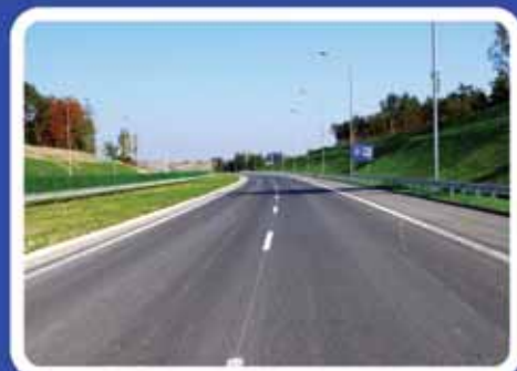
Odcinek autostrady węzeł Tarnów Północ - węzeł Dębica Wschód
