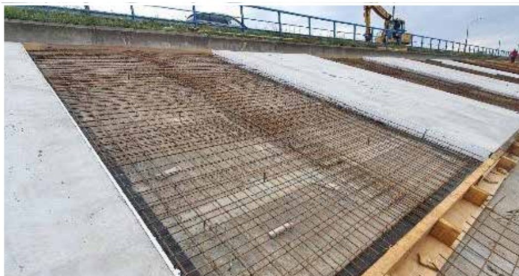
◀ Widok na zamontowane zbrojenie płyty parzystej
