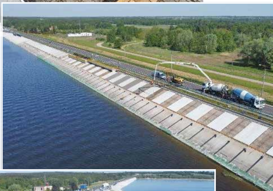
◀ Widok z drona na prowadzone prace przy topieniu materaców gabionowych
