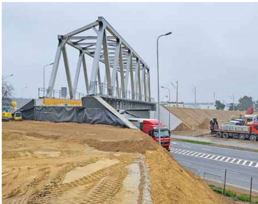
Nowy jednoprzęsłowy stalowy wiadukt w Rudnej Małej nad drogą krajową nr 9 Rzeszów-Warszawa
