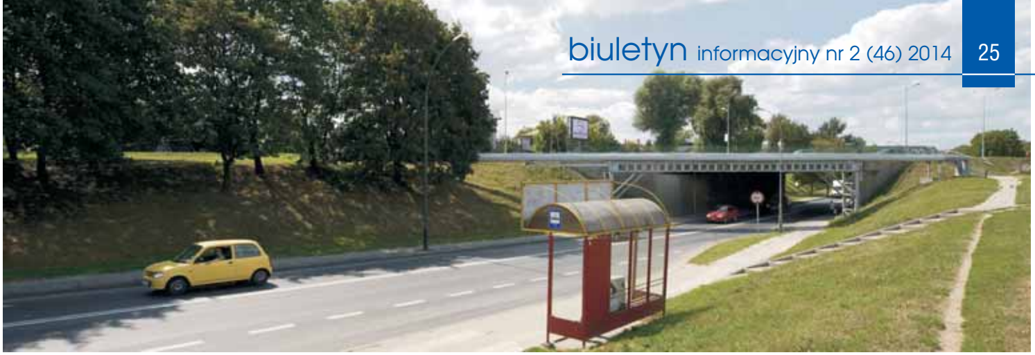
Al. Wyzwolenia przed przebudową - fot. wykonana 7 sierpnia 2012 r.
