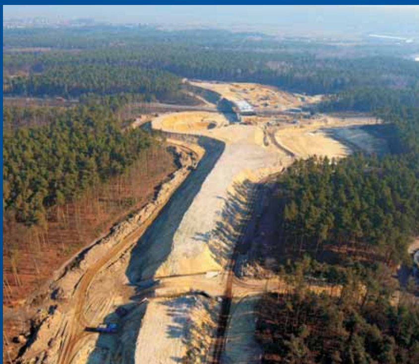
Nasyp przeciążeniowy na trasie głównej oraz łącznicy
