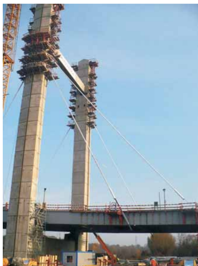
Rys.7. Konstrukcja stalowa mostu w położeniu docelowym
