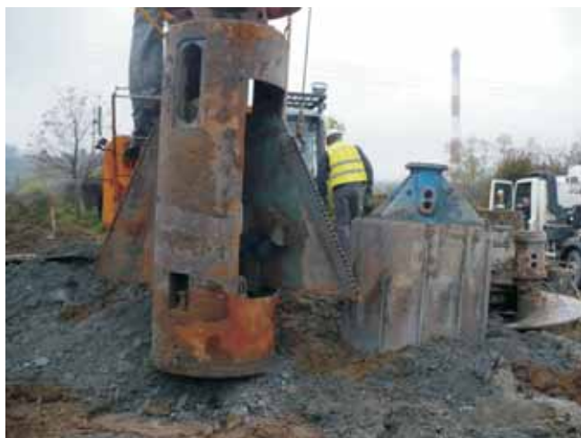
Rys.2. Wykonywanie pali fundamentowych z użyciem specjalnego rozwiertaka
