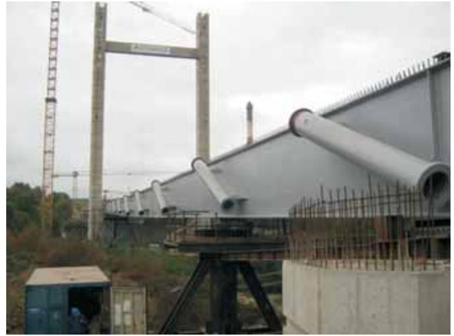
Rys.5. Konstrukcja stalowa mostu na placu scalania
