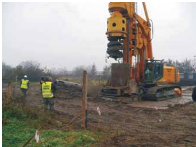
Rys.3. Wykonywanie fundamentu i ławy pod pylon
