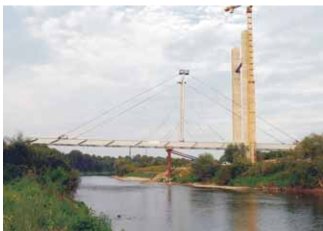
Rys.6. Konstrukcja stalowa mostu podczas nasuwania
