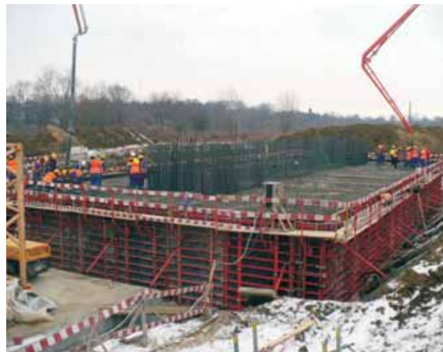
Rys.3. Wykonywanie fundamentu i ławy pod pylon
