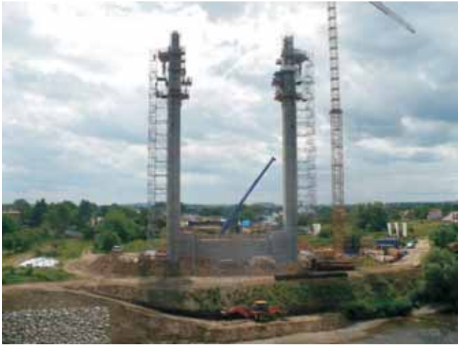
Rys.4. Budowa pylonu: deskowania ślizgowe, rusztowanie pod rygiel i stalowe zakotwienia, wewnątrz słupa pylonu
