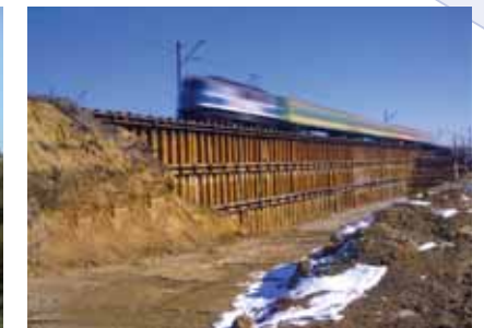
2011 I miejsce – „Budowa wiaduktu kolejowego” – Paweł Łukawski
