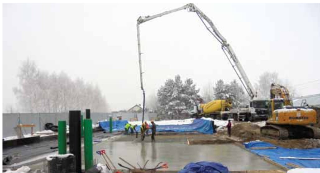
17.01.2017 r., Rzeszów – Plac budowy siedziby PDK OIIB, etap betonowania, beton podkładowy pod płytę fundamentową
