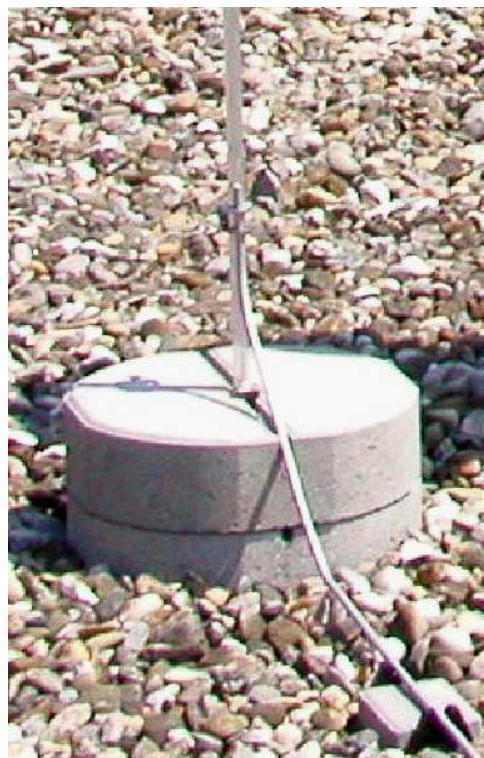
Rys. 4. Łączenie betonowych podstaw zwodów pionowych o wysokości 2 - 3 m
