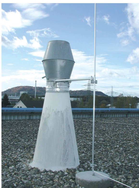
Rys. 5. Zwody pionowe mocowane do chronionego urządzenia
