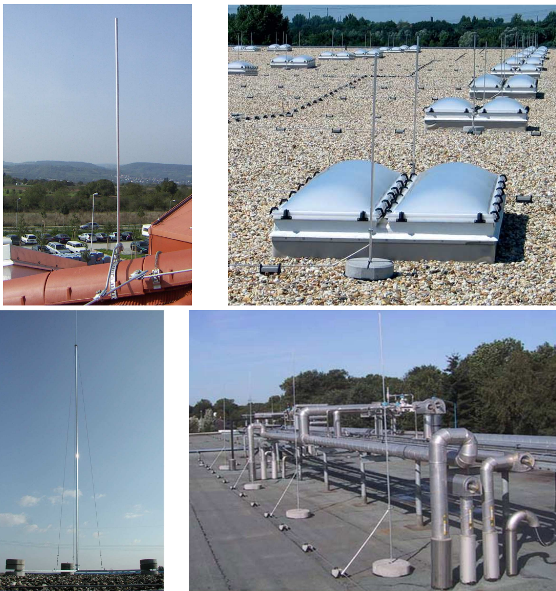
Rys. 2. Przykłady rozwiązań zwodów pionowych na dachu płaskim
