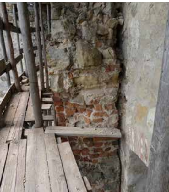
Fot. 3 Widok oddzielenia się nieprzewiązanej ściany wtórnej od pierwotnych ścian zamku wysokiego- część górna (fot. L. Buda-Ożóg)
