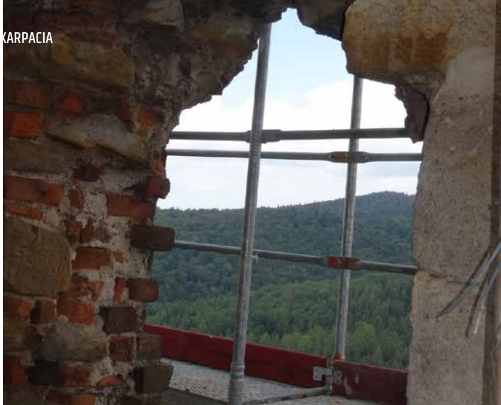
Fot. 4 Wyplukanie zaprawy spajającej łęk kamienny nad otworem okiennym
