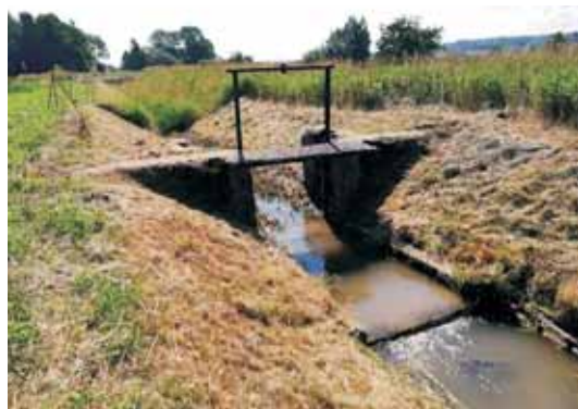
Widok na zastawkę przed pracami remontowymi w 2021 r. – widok od strony wody dolnej.
