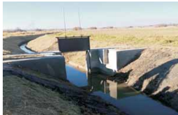
Zastawka betonowa na potoku Marcinek po remoncie – widok od strony wody górnej.
