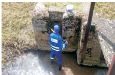
Prace związane z odtworzeniem zastawki piętrzącej na potoku Marcinek w Krośnie – widok na lewy przyczółek budowli.
