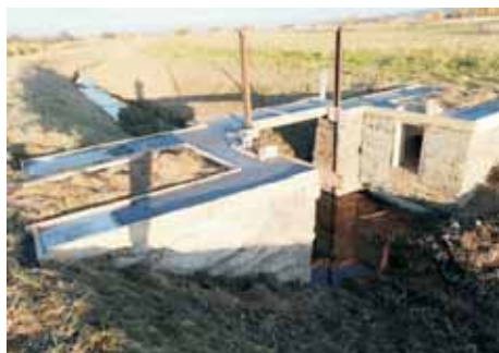
Widok na zastawkę w trakcie prac remontowych
