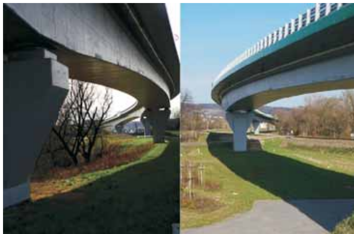
Widok na estakadę w ciągu Obwodnicy Czudca - łuk obiektu omija zadrzewienia łęgowe
