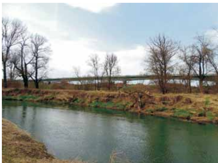
Rzeka Wisłok objęta siecią Natura 2000, na drugim planie estakada w ciągu Obwodnicy Czudca
