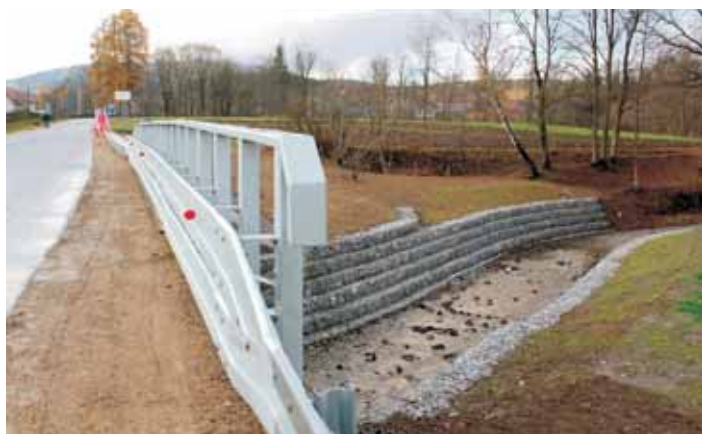
Stabilizacja osuwiska wraz z odbudową drogi powiatowej Nr 1905R Kąty - Desznica - Świątkowa Wielka - Świątkowa Mała w km 10+060 - 10+105 w m. Świątkowa Wielka
