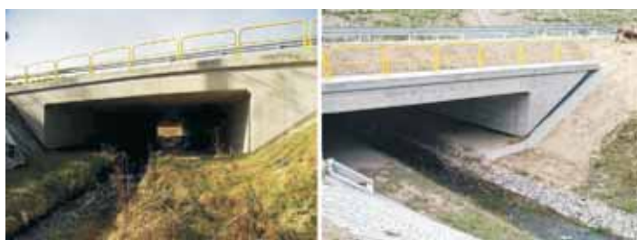
Obiekt inżynierski zintegrowany z ciekim dostosowany do funkcji przejścia dla małych zwierząt w ciągu Obwodnicy Czudca
