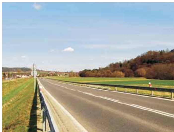
Fragment Obwodnicy Czudca z widokiem na pola uprawne w dolinie rzeki Wisłok oraz porośnięte lasem pagórki
