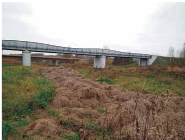
Most kolejowy i drogowy nad rzeką Wisłok stanowiącą korytarz ekologiczny
