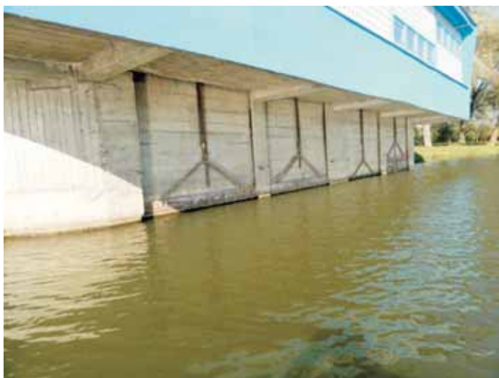
Budynek ujęcia wody na rzece Wisłok - widok na kraty rzadkie
