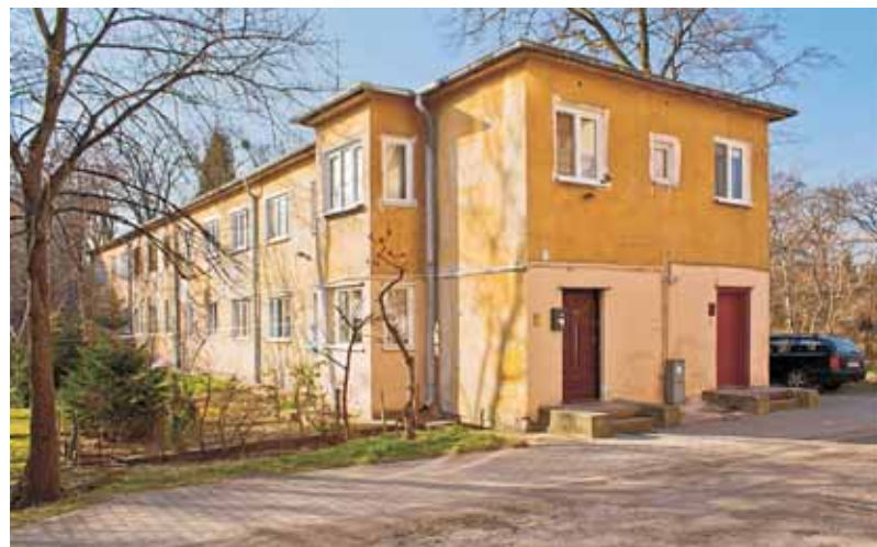
Fot. 1. Dom ośmiorodzinny przy ul. Tramwajowej 2a (stan na 2014 r.)
