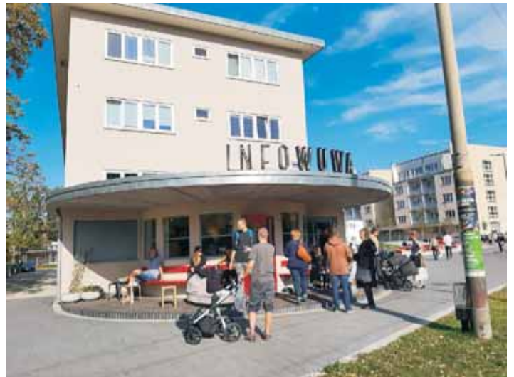
Fot. 7. Kawiarenka urządzona w budynku przy ul. Tramwajowej 2 będąca jednocześnie punktem informacyjnym WuWA
