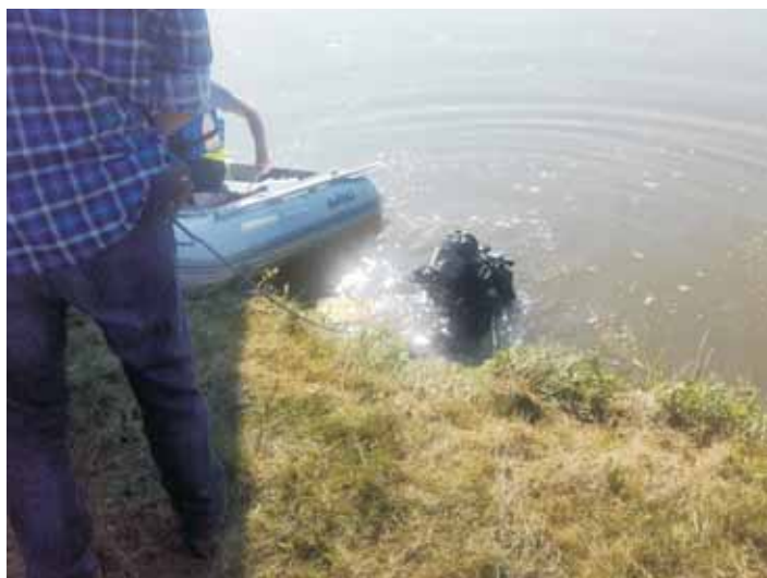
Rozpoczęcie montażu sit przez nurków
