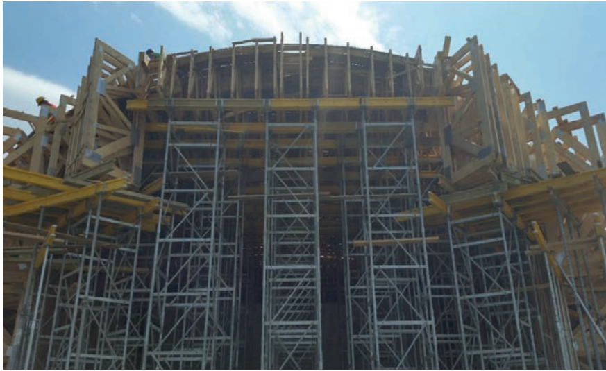
Rys. 8. Konstrukcja szalunków z podporami
