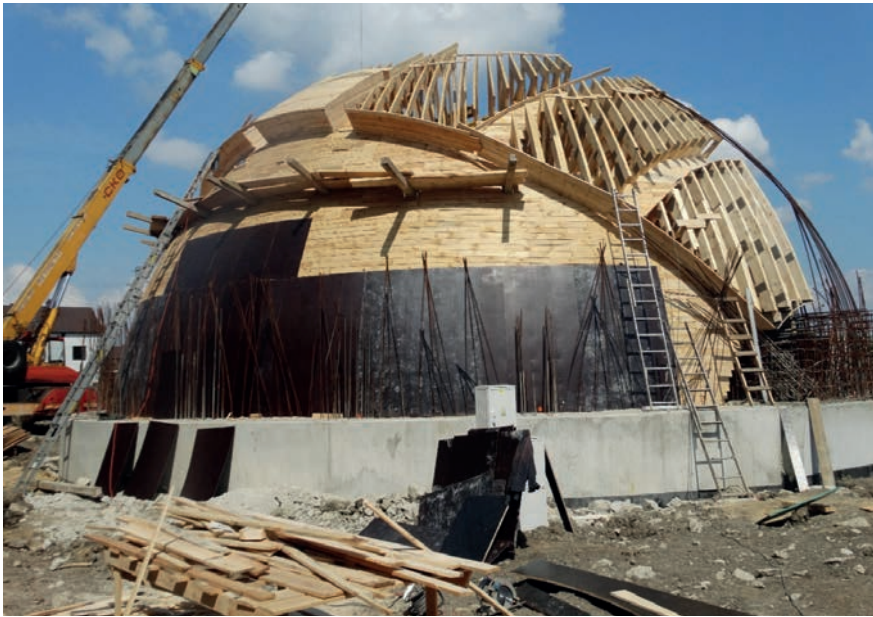
Rys. 9. Deskowanie kopuły sceny
