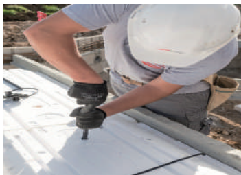
Fot. Montaż instalacji podposadzkowych.
