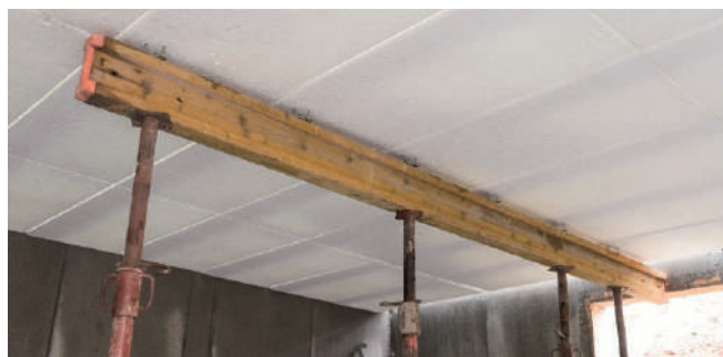
Fot. Montaż bezpodporowy (po lewej stronie) oraz z zastosowaniem podpór montażowych (po prawej stronie)
