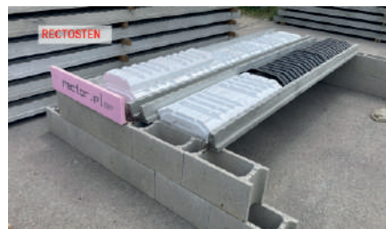
Fot. Montaż systemu Rectosten.
