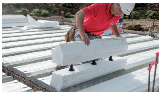
Fot. Docinanie elementów Rectosten.
