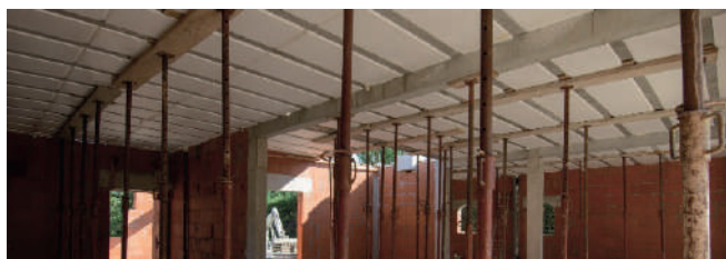
Fot. Montaż bezpodporowy (po lewej stronie) oraz z zastosowaniem podpór montażowych (po prawej stronie)
