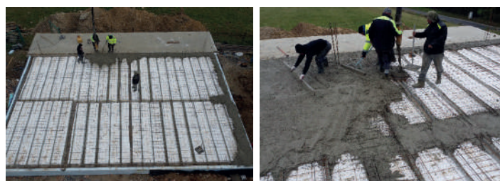
Fot. Betonowanie stropu Rectosten.
