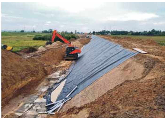
Trześniówka VII – wykonywanie przesłony w korpusie obwałowania
