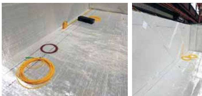
Rys. 7. Montaż światłowodów: a) w laminacie okładziny dolnej; b) w laminacie żebra
