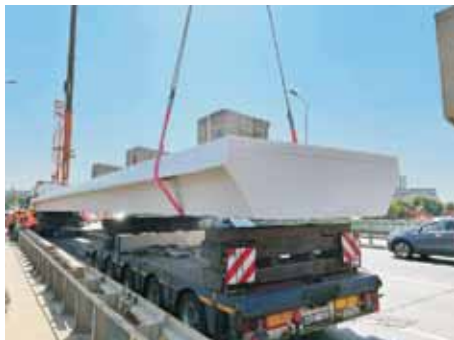
Rys. 5. Montaż przęsła kładki: a) transport przęsła; b) montaż przęsła za pomocą dźwigów; c) wszystkie przęsła kładki na podporach
