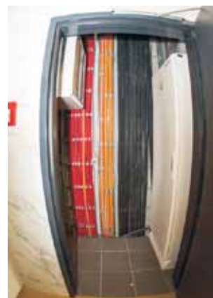
Układanie przewodów na drabinkach
