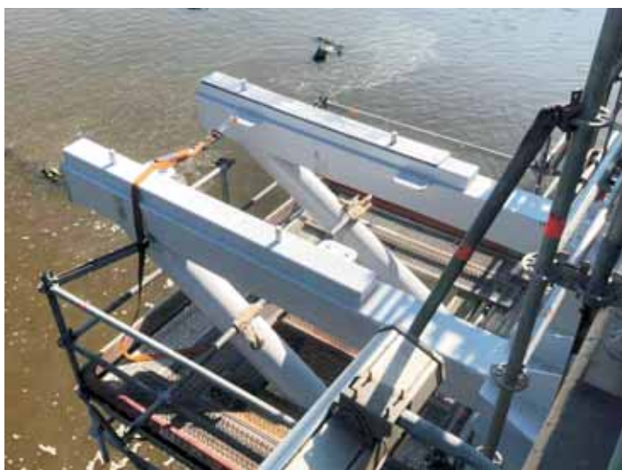
Rys. 4. Wspornik stalowy mocowany do istniejącej podpory
