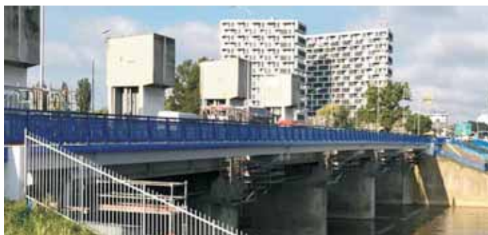
Rys. 8. Gotowa kładka kompozytowa: a) widok z boku; b) widok z góry
