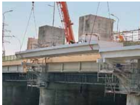
Rys. 5. Montaż przęsła kładki: a) transport przęsła; b) montaż przęsła za pomocą dźwigów; c) wszystkie przęsła kładki na podporach
