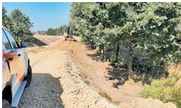
Prace przygotowawcze na zadaniu „Osa”
