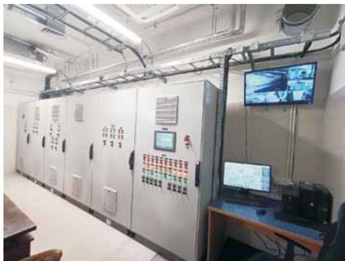
Wizualizacja i sterowanie pracą maszynowni chłodniczej
