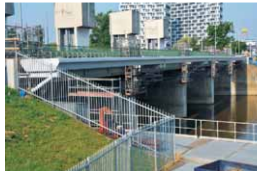
Rys. 5. Montaż przęsła kładki: a) transport przęsła; b) montaż przęsła za pomocą dźwigów; c) wszystkie przęsła kładki na podporach
