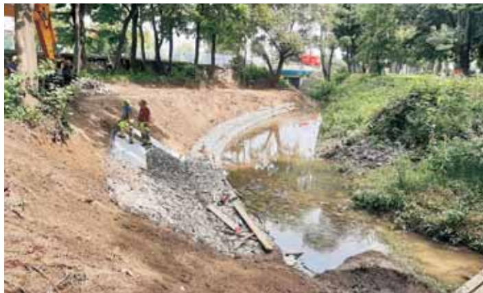
Umocnienia stopy skarpy na potoku Zawadka
