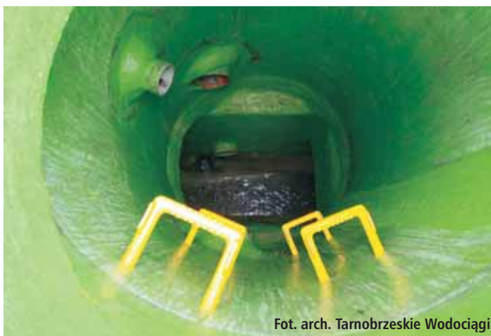
Studnia po renowacji panelem GRP
