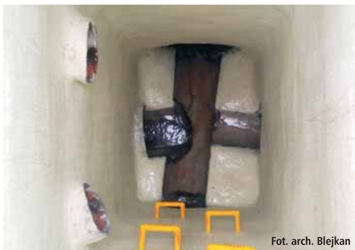
Studnia po renowacji chemią budowlaną
