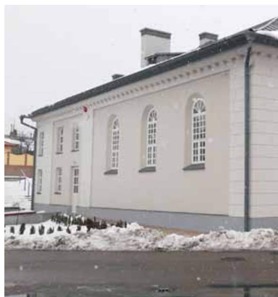
Budynek po zakończeniu inwestycji
