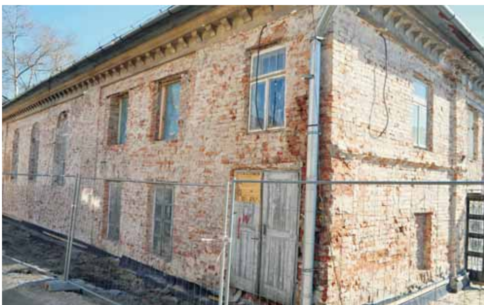
Narożnik budynku od strony północno-zachodniej - w trakcie realizacji inwestycji
