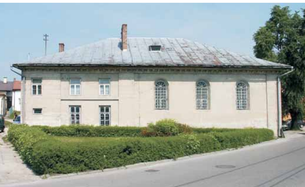
Elewacja południowa - przed przebudową
