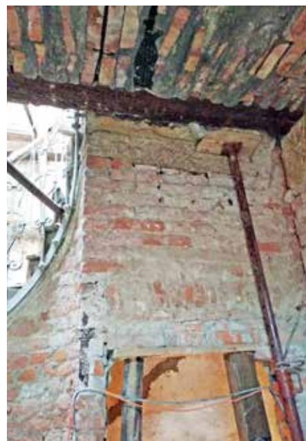
Wnętrze budynku dworca przed renowacją
