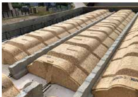
Fot. Montaż stropów Rectolight.
