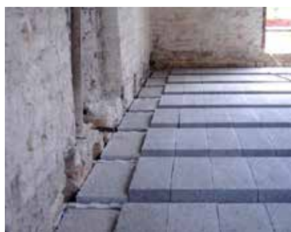
Fot. Strefa obniżona pod wieniec na stropie.
