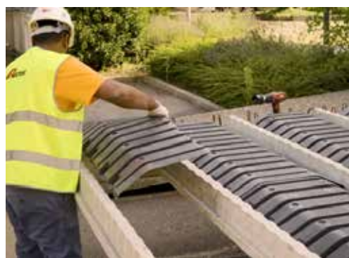
Fot. Montaż paneli Rectoplast.
