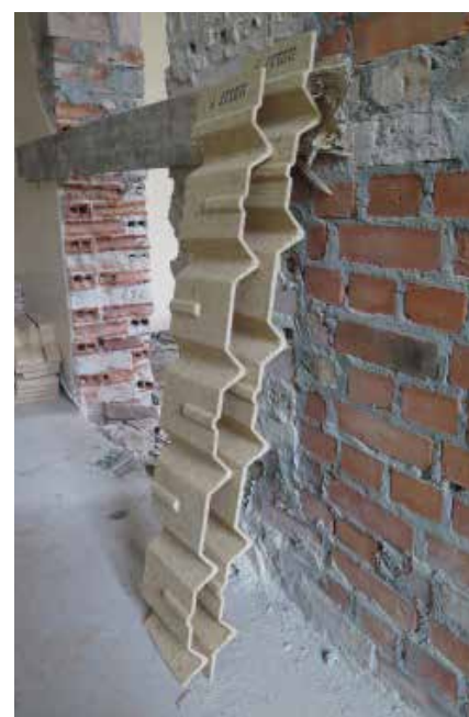
Fot. Docięte panele Rectolight.
