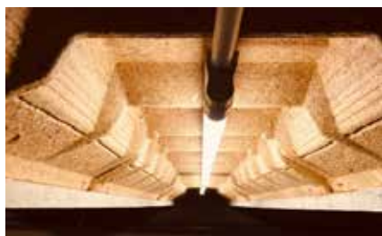
Fot. Montaż oświetlenia w grubości stropu.
