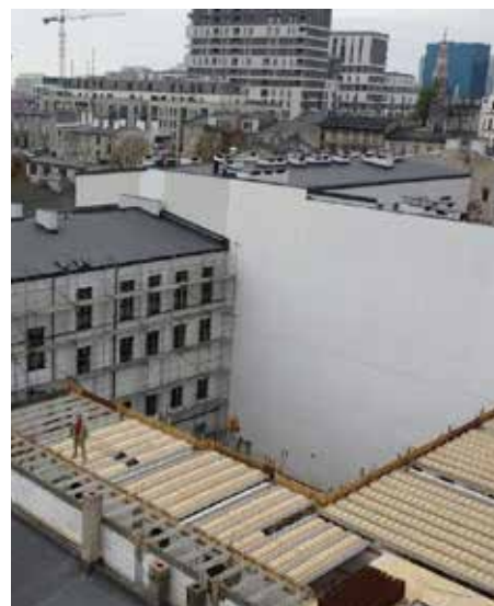
Fot. Strop Rectolight podczas rozbudowy oficyny.
