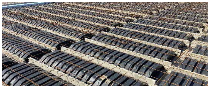
Fot. Montaż paneli Rectoplast – strop nad przestrzenią wentylowaną.
