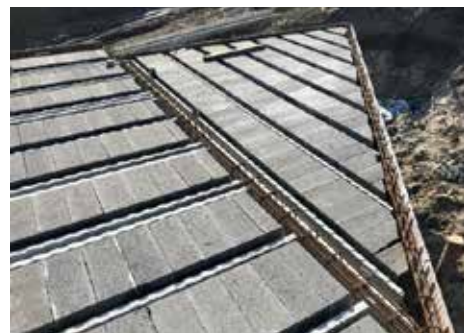
Fot. Docięcie pustaków pod kątem
