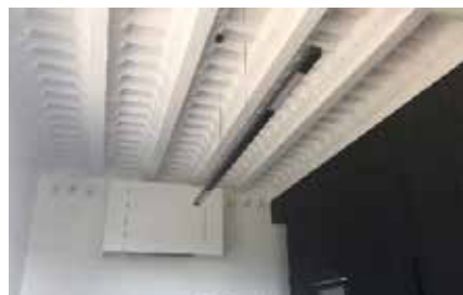
Fot. Strop Rectolight podczas wymiany stropów.
