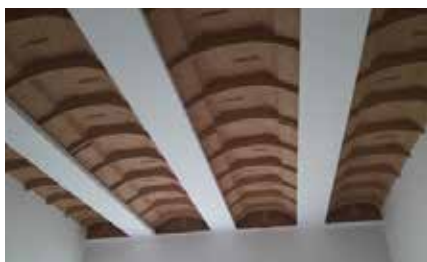
Fot. Strop Rectolight bez wykończenia sufitem podwieszanym.
