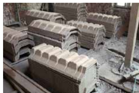
Fot. Strop Rectolight podczas wymiany stropów.
