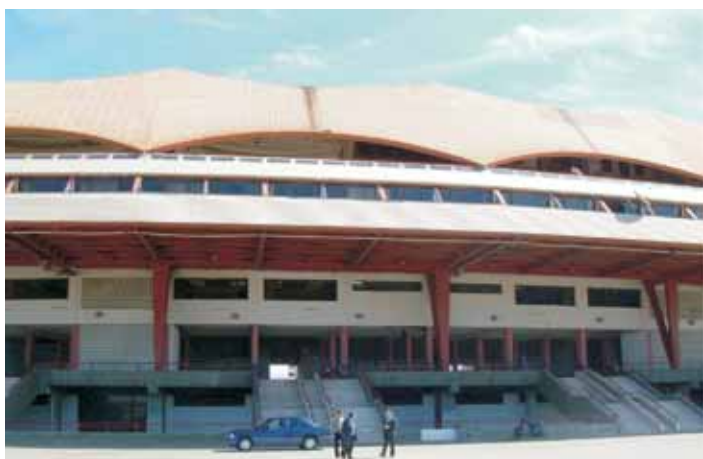
Widok hali widowiskowej (fotografia własna)
