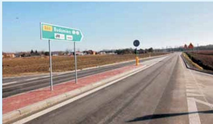
Budowa obwodnic Oleszyc i Cieszanowa
