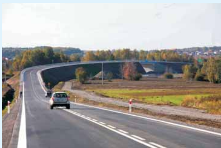
Budowa obwodnicy Kolbuszowej i Weryni w ciągu DW875
