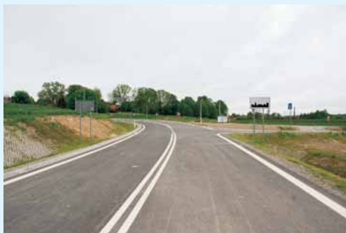
Budowa obwodnicy Sędziszowa Młp. w ciągu DW987
