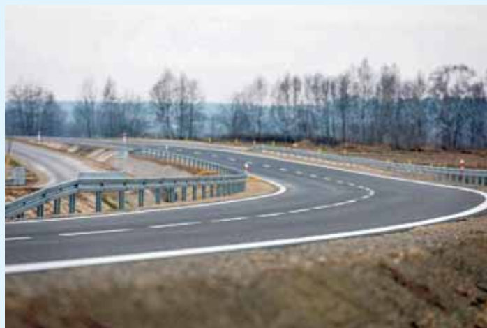
Budowa północnej obwodnicy Sokółowa Młp. w ciągu DW875
