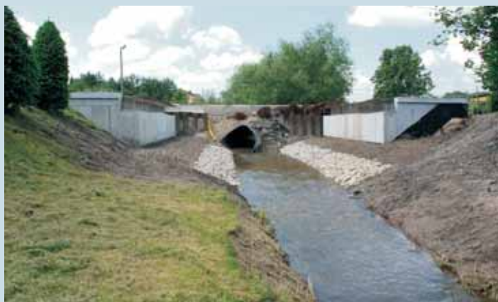
Rozbudowa DW 885 Przemyśl - granica Państwa
