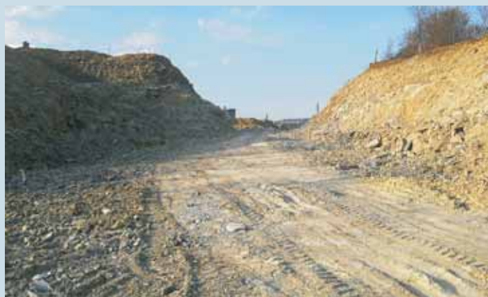
Budowa nowego odcinka drogi wojewódzkiej nr 992 w Jaśle
