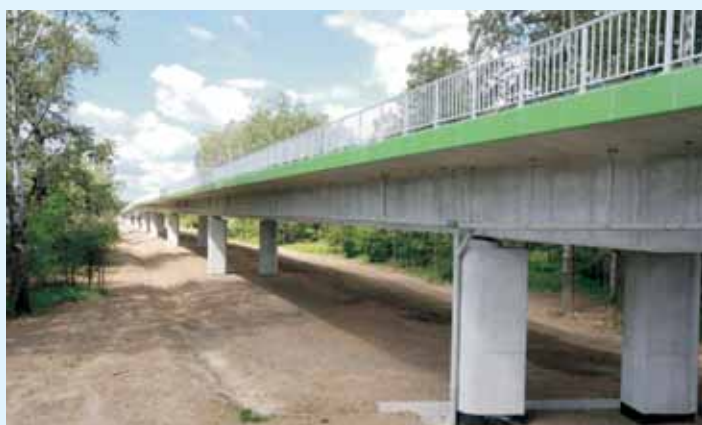
Obwodnica Mielca wraz z mostem przez Wisłokę DW 984
