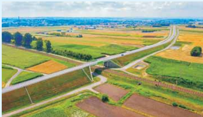
Budowa DW 835 na odcinku od węzła A4 „Przeworsk” do DK 94 (Gwizdaj)
