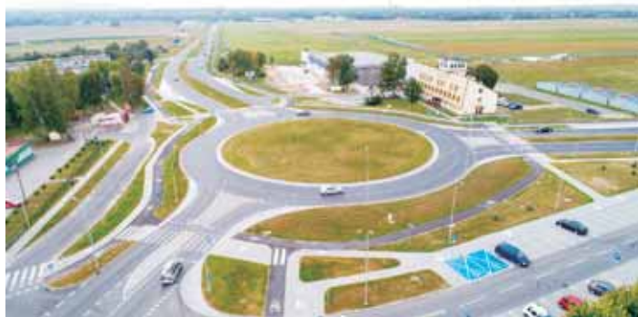
Rozbudowa DW 869 od S-19 do DK9, etap II
