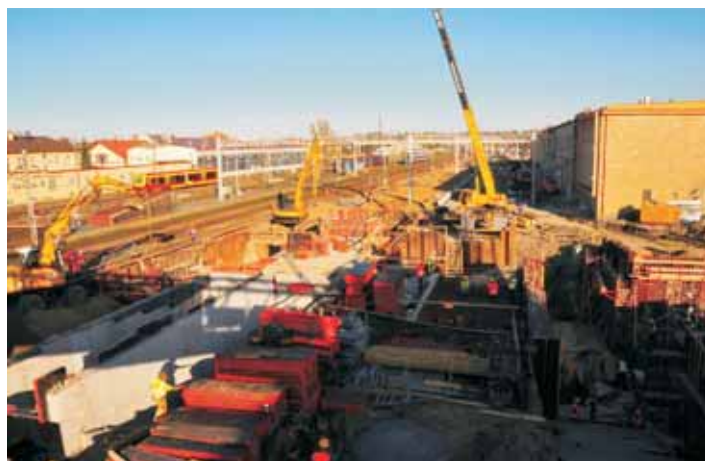
Prace przy rozbudowie tunelu widziane z poziomu kładki.
