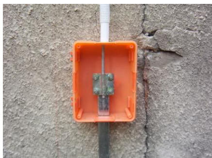
Rys. 2. Przykładowy sposób osłony przewodów i złącza ZK na ścianie z użyciem skrzynki probierczej ściennej i rury ochronnej.
