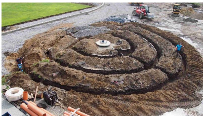
Rys. 6. Widok wykopanych kręgów pod montaż uziemienia ochronnego masztu.
