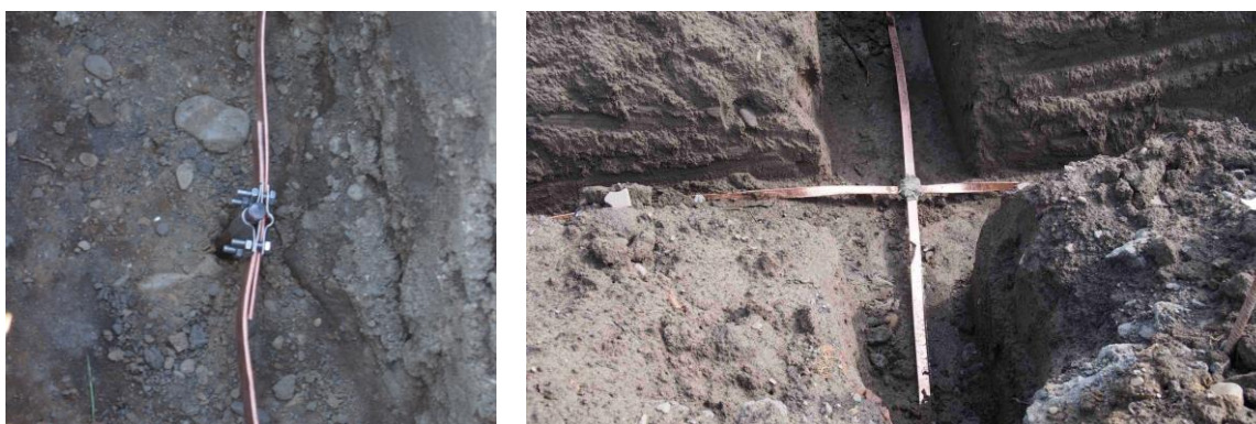
Rys. 9. Widok wykonanych połączeń elementów uziemienia masztu oświetleniowego.
