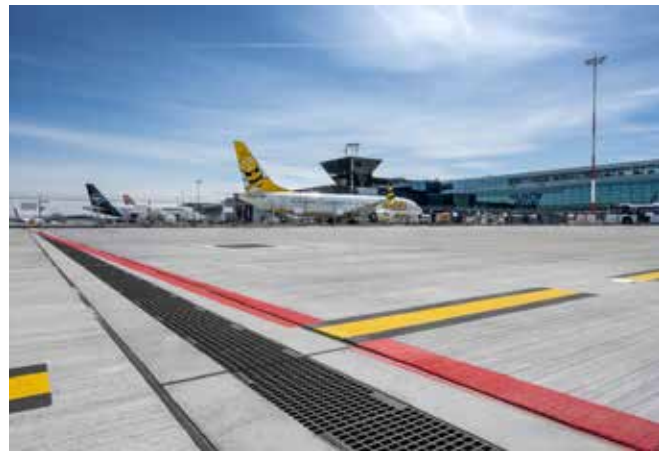
Fot. Archiwum HAURATON Polska – odwodnienie liniowe w prefabrykowanej obudowie żelbetowej na płycie lotniska w Balicach
