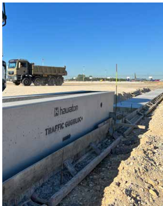
Fot. Archiwum HAURATON Polska – odwodnienie liniowe w prefabrykowanej obudowie w trakcie montażu
