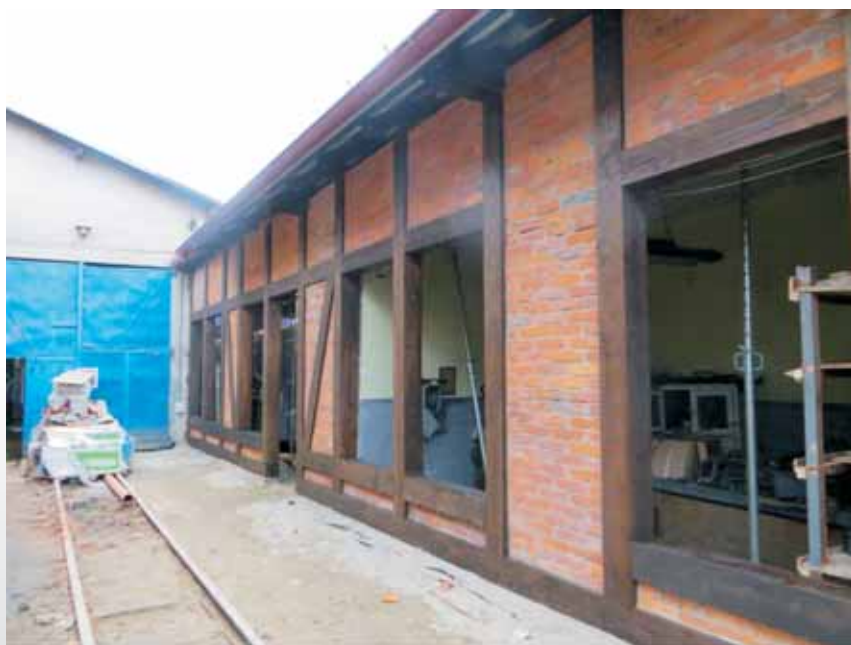
Archiwalne zdjęcie z trwających prac remontowych lokomotywowni i hali napraw wagonów, ze zbiorów WUOZ w Przemysław
