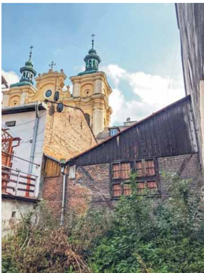
Elewacja od strony podwórza. Stan obecny Fot. Aleksander Busz
