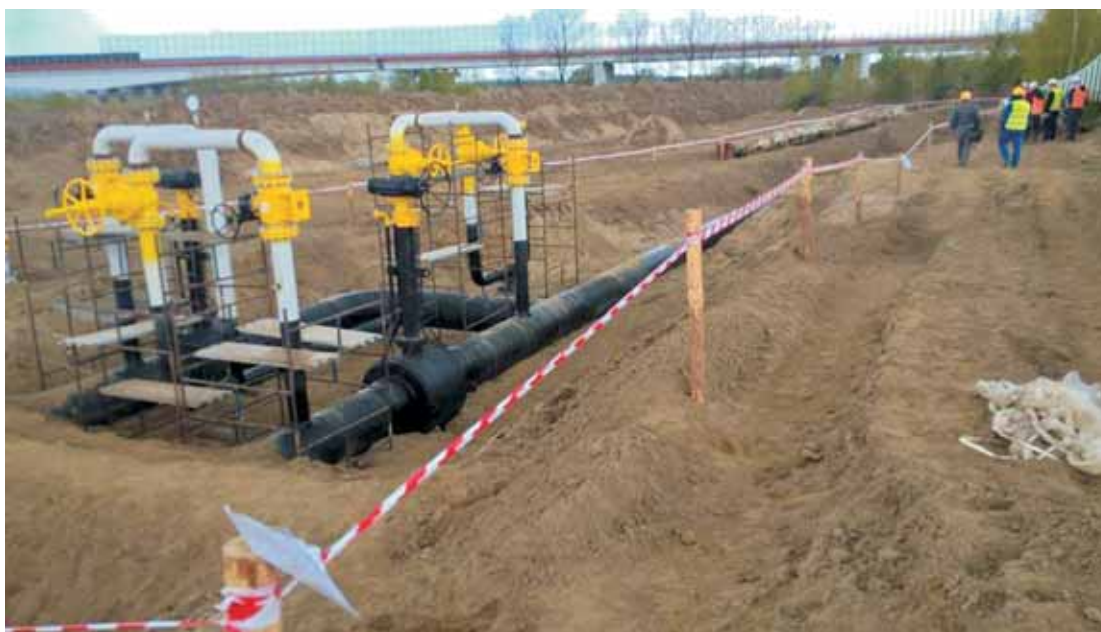
Przebudowa gazociągu wysokiego ciśnienia zrealizowana w trakcie rozbudowy obwałowań Wisłoki w Dębicy
