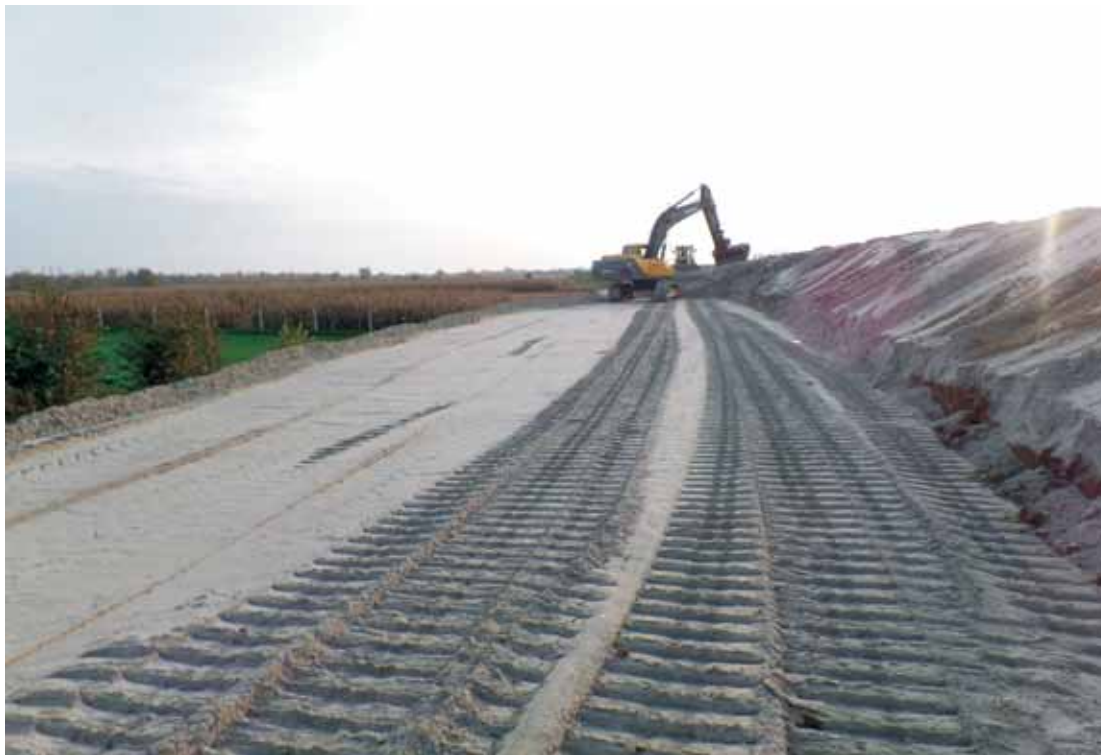
Trwają roboty budowlane na zadaniu Trześniówka VII
