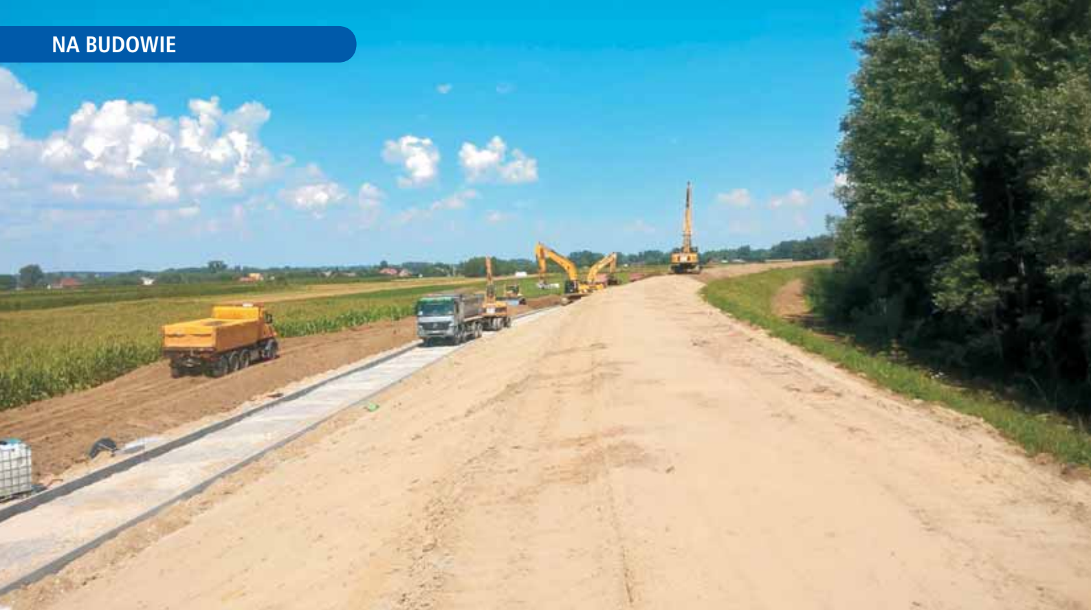
Zadanie San III - rozbudowa 4,5 km obwałowania zakończona w październiku 2020 r.
