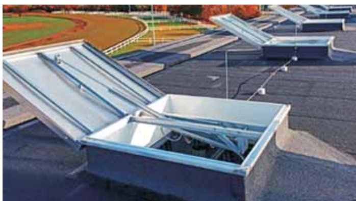
Rys. 4. Zadziałanie klapy oddymniającej
