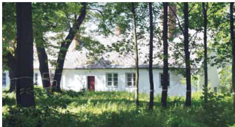
Budynek oficyny dworskiej, stan 2013, widoczne stalowe elementy pozostawione po placu zabaw
