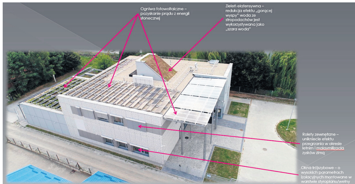
Budynek Podkarpackiej Okręgowej Izby Inżynierów Budownictwa jest przyjazny środowisku
