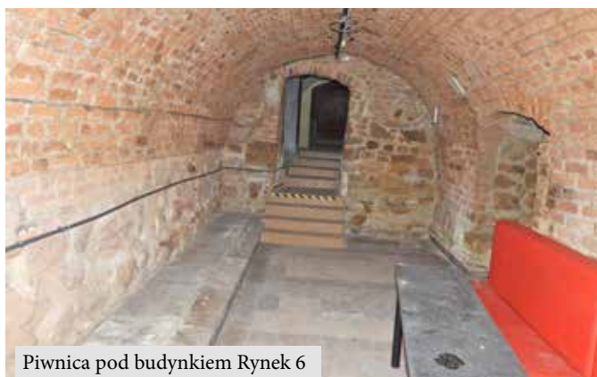
Istniejące główne drewniane schody na piętro w kamienicy Rynek 6
