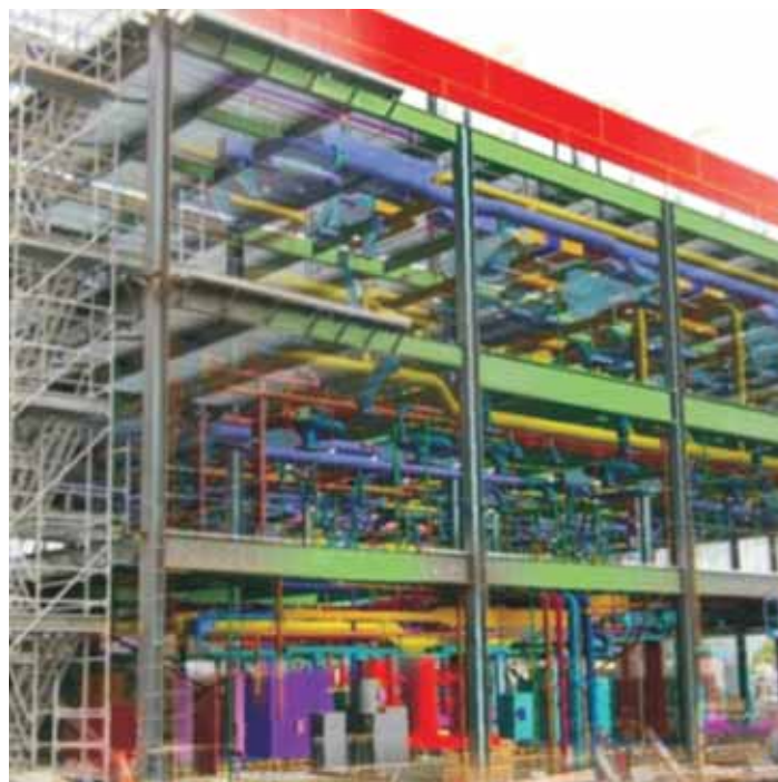
Rys. 2 Gęszcz instalacji niemożliwy do pomiaru metodami klasycznymi Źródło: http://faro.com
