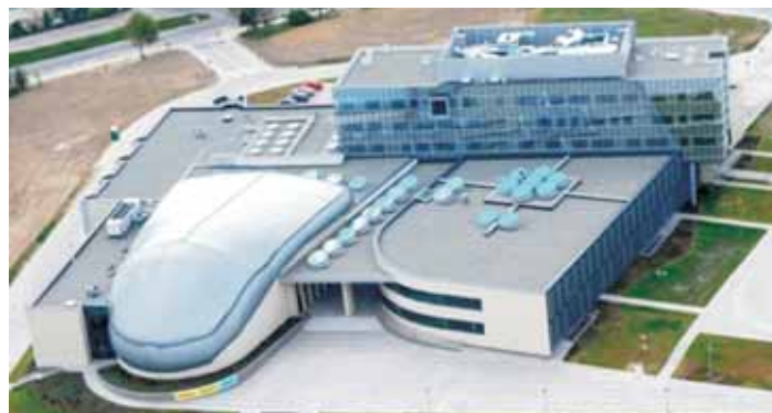
Rys. 6 Flagowy budynek „V” Politechniki Rzeszowskiej Źródło: Gajdek 2014/5
